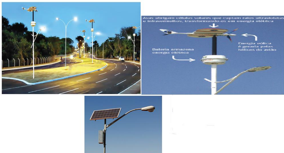
Fig. 3.16. - Postes de iluminação alimentados por energia solar e/ou eólica
