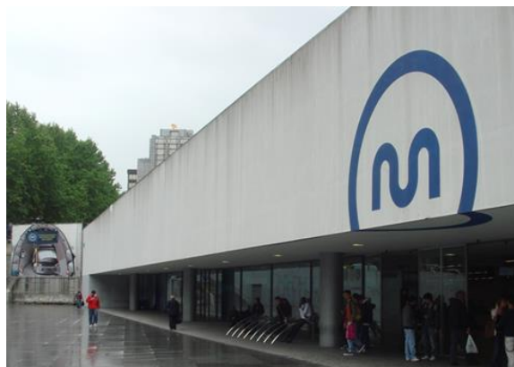
Fig. 2.19. - Suporte de bicicletas – Estação de Metro da Trindade
