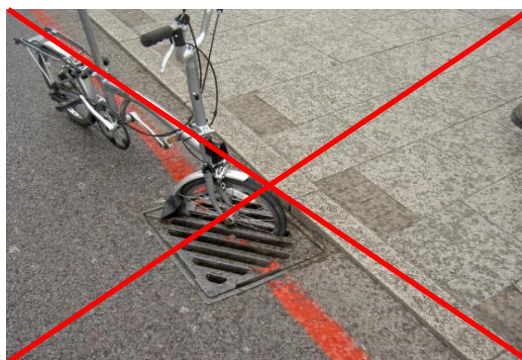
Figura 3.14. - Exemplo de grelhas metálicas inadequadas para ciclovias [50]
