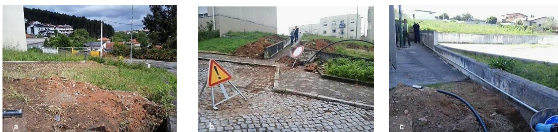
Figura 72: a) Limpeza do terreno; b) e c) Instalação da Rede de abastecimento de água. Fonte: C.M.GAIA, 2014.
