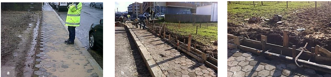
Figura 65: a) Reconstrução do passeio; b) e c) Delimitação dos talhões de cultivo com estacas. Fonte: C.M.GAIA, 2012
