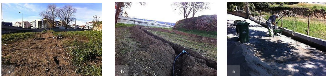
Figura 82: a) Limpeza do terreno; b) Instalação da rede de abastecimento de água; c) Construção do muro. Fonte: C.M.GAIA, 2014
