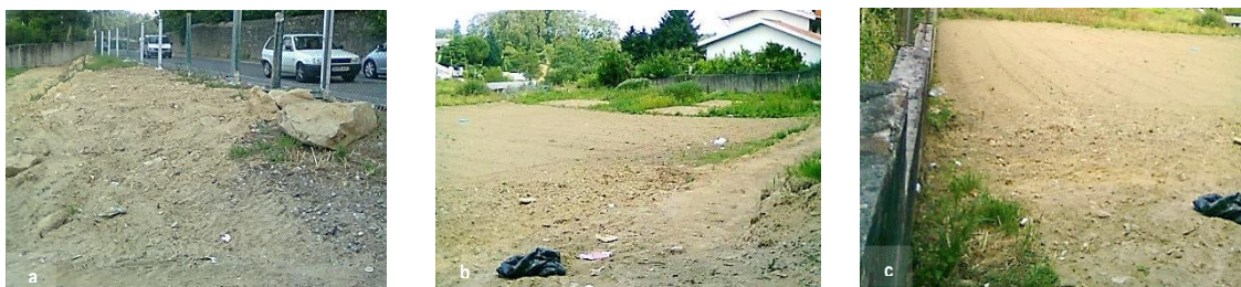
Figura 97: a), b) e c) Limpeza do terreno. Fonte: Autor, 2014
