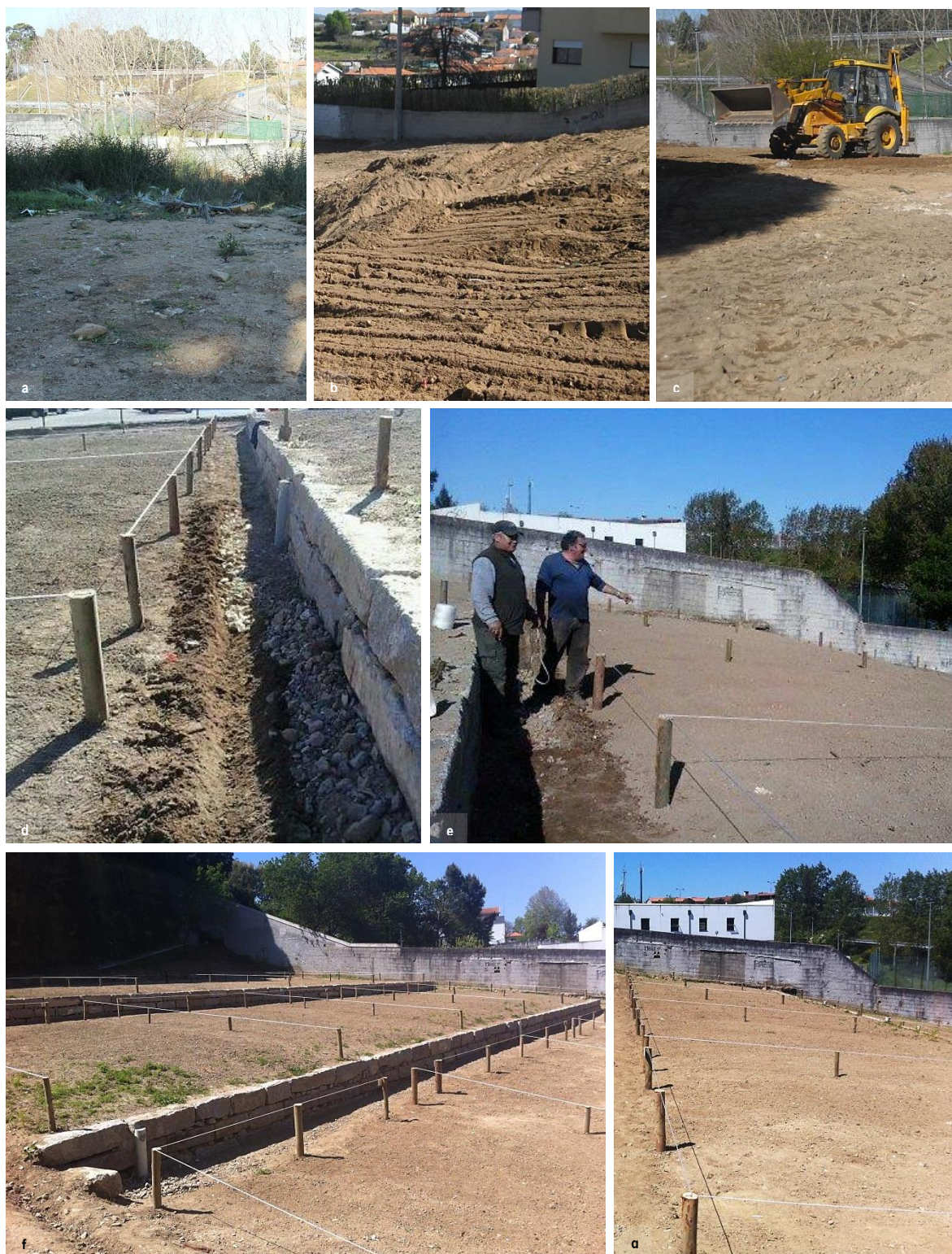
Figura 11: Construção da horta urbana de Gervide. a) Terreno existente; b) Prospeção do solo; c) Limpeza do terreno; d) Instalação da rede de distribuição de água; e) Colocação das divisórias dos talhões com corda; f) e g) Horta pronta a ser cultivada. Fonte: C.M. GAIA, 2013.
