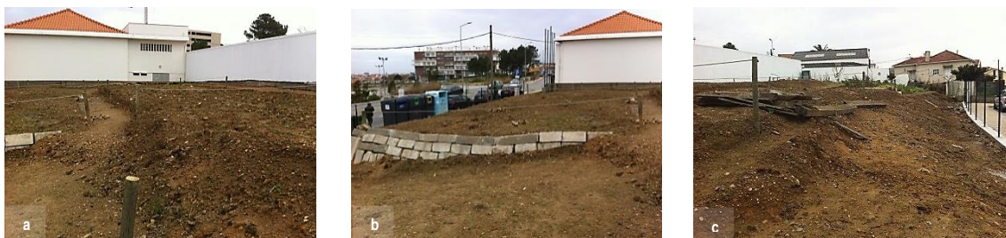
Figura 44: a) Modelação do terreno; b) Reconstrução do muro de suporte; c) Reconfiguração do talude. Fonte: C.M.GAIA, 2013
