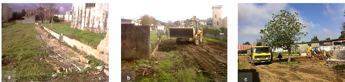
Figura 51: a) Limpeza do terreno; b) Transferência de terra para a horta; c) Modelação do terreno. Fonte: C.M.GAIA, 2012
