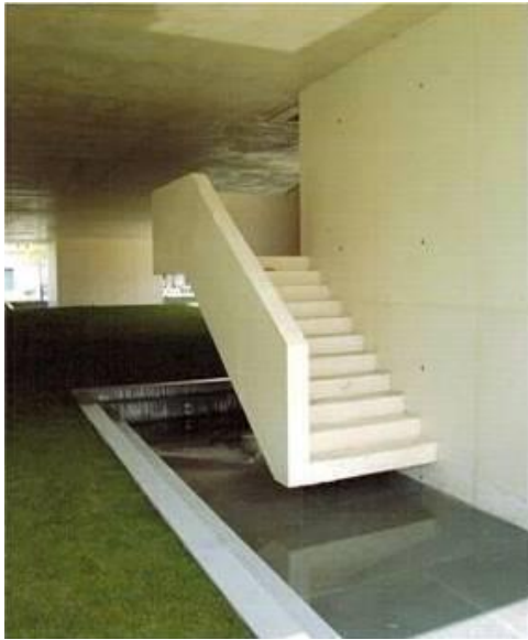
Espelho de água e escada de emergência adossada ao pilar Poente/Sul Fonte: Biblioteca Municipal. Viana do Castelo: Camara Municipal de Viana do Castelo [2008?]. Brochura
