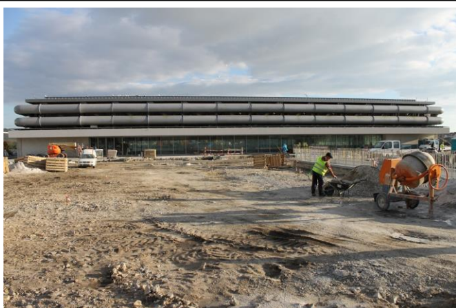
Vista da Fachada Norte em fase de construção Março de 2013 Fotografia: AT
