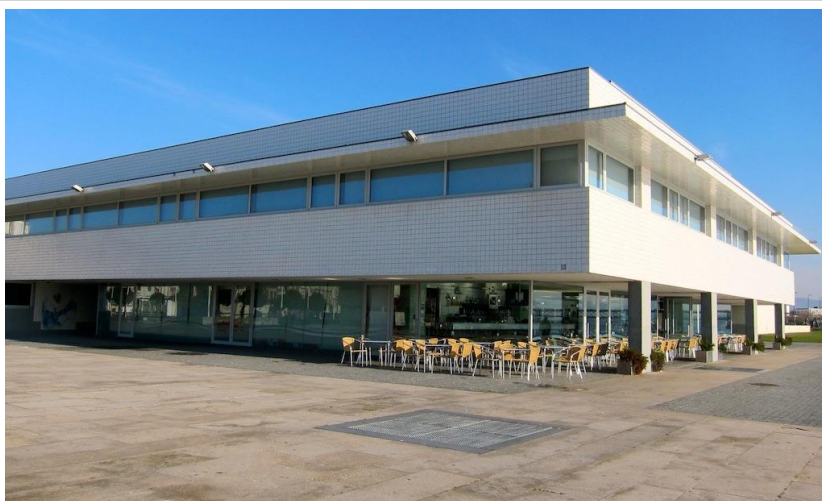
Edifício Nascente Disponível em: http://1.bp.blogspot.com/-fuy-3n3_kjY/Tx_2Ixpual/AAAAAABDA/xDGE1aC8Rtl/s1600/Tribunal+Trabalho+Viana.jpg
