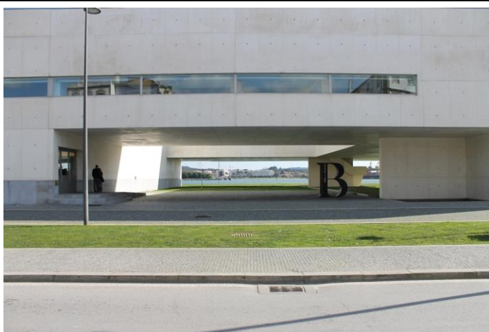
Vista da Fachada Norte com o rio Lima em segundo plano. Fotografia: AT
