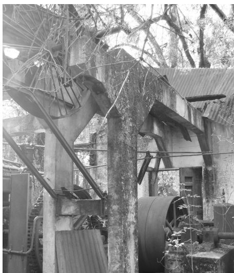
IMG. 50 INTERIOR DA CENTRAL BIEL
