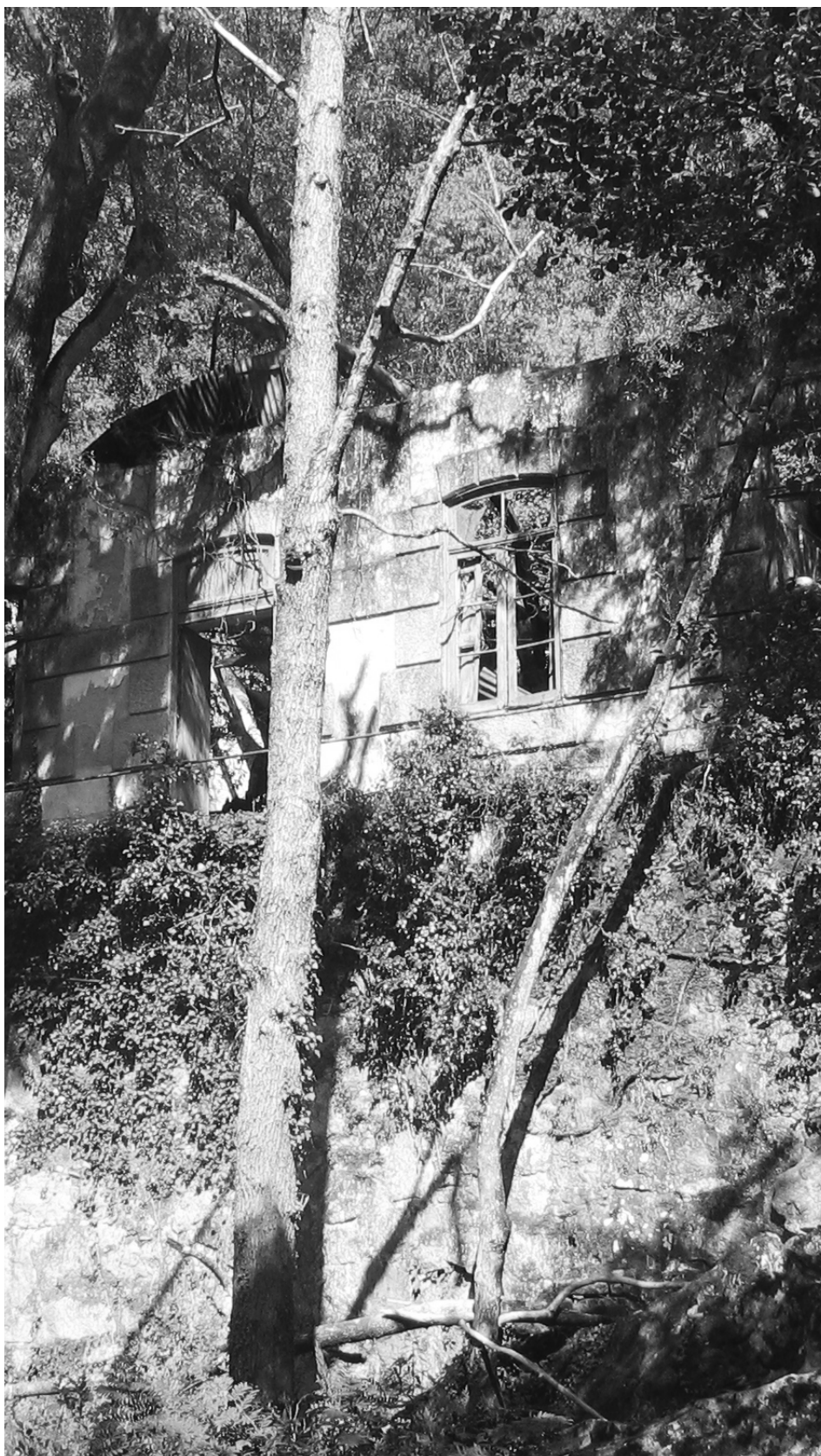
IMG. 15 FOTOGRAFIA CENTRAL DO BIEL
