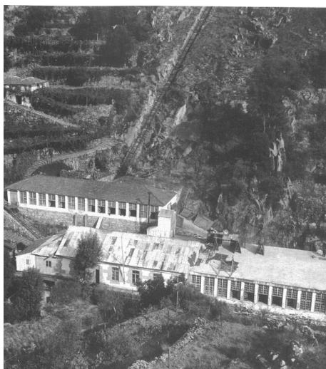
IMG. 44 FÁBRICA DE CURTUMES DE J.P. GRANJO, NA ANTIGA CENTRAL DO BIEL, 1945
