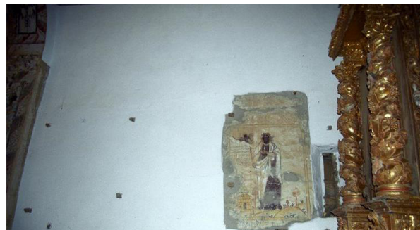
fig.41- Interior da capela mor- parede lado do Evangelho
