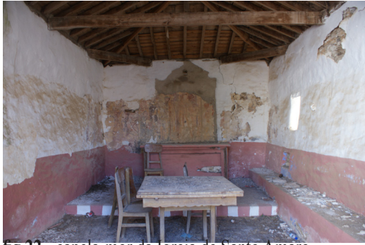
fig.22 - capela-mor da Igreja de Santo Amaro
