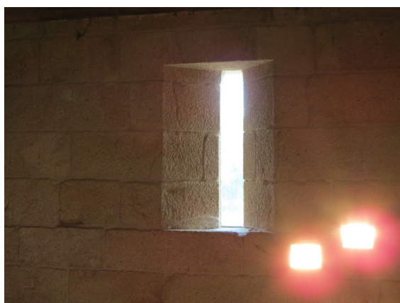
fig. 65- Vão na nave da igreja de N.ª.S.ª. de Guadalupe
