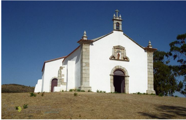
fig.37- Fachada lateral Norte e principal Poente
