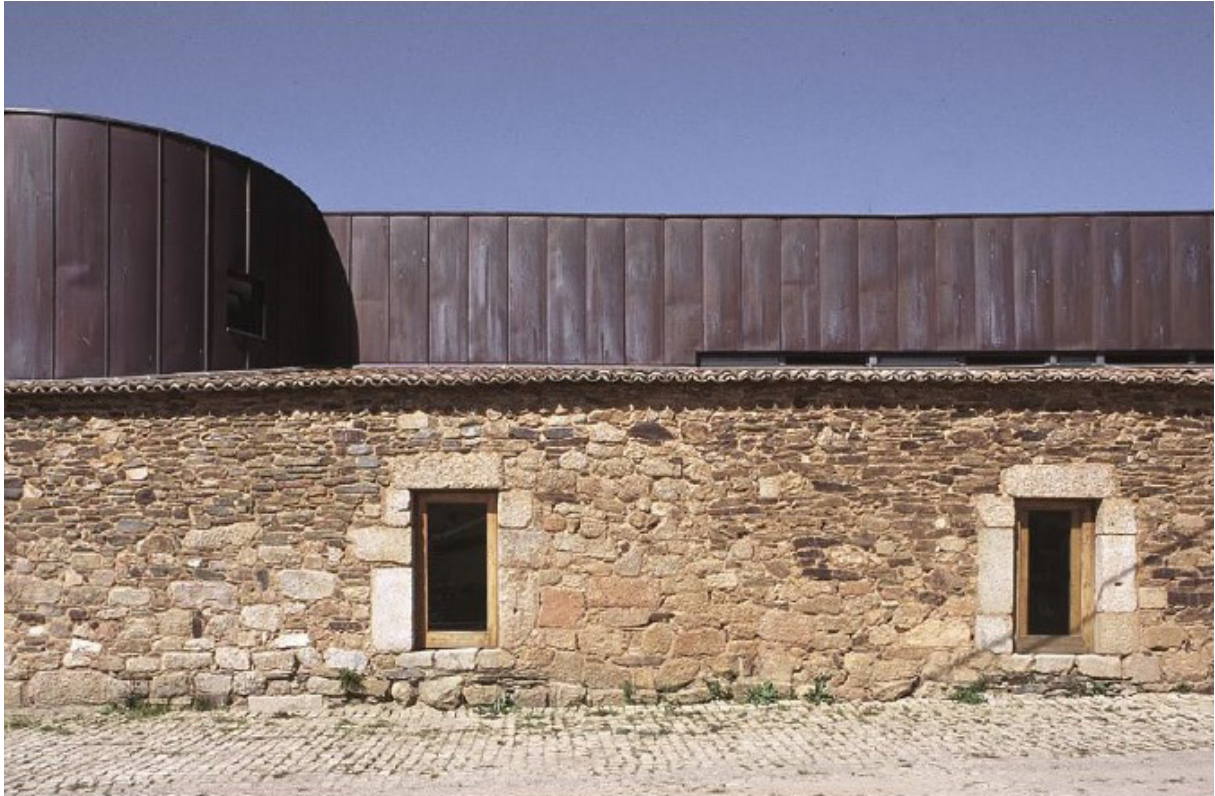
fig. 106- Intervenção de Alexandre Alves Costa e Sérgio Fernandez (Atelier 15) em Idanha-a-Velha - binómio novo-antigo de material num conjunto de palheiros
