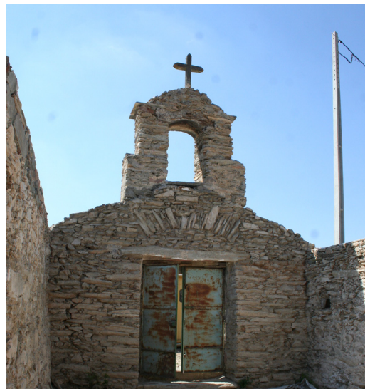
fig.82 - Alçado interior da nave após a picagem do reboco
