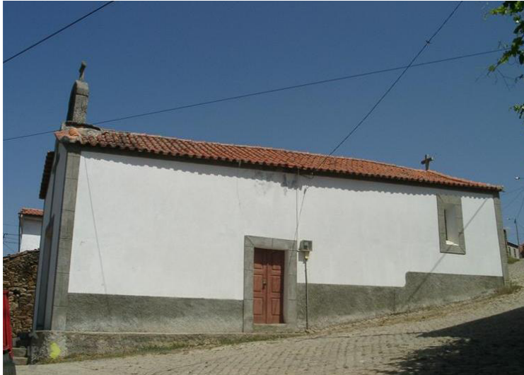
fig.55- Fachada Sul da capela dos Divinos Milagres
