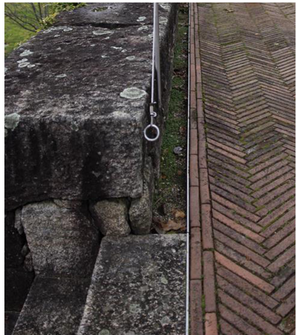
fig. 108- Pousada de Santa Maria de Bouro - aplicação de guia metálica
