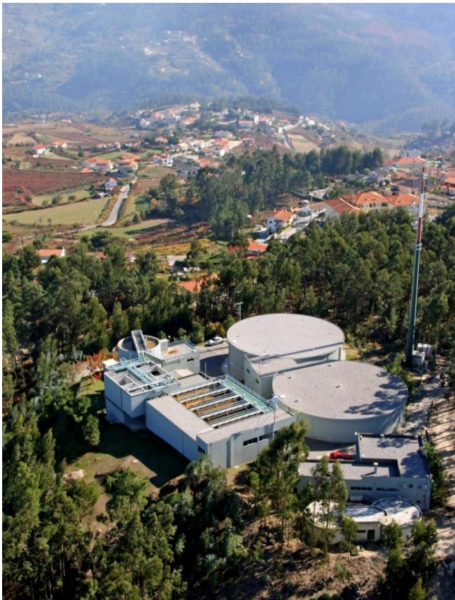
Figura 26 ETA Castelo de Paiva
