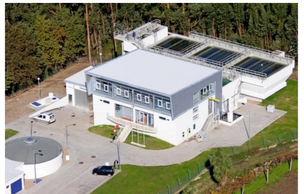
Figura 28 ETA do Ferro
