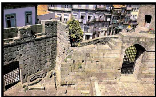
Figura 23: Ruínas Andares Inferiores
