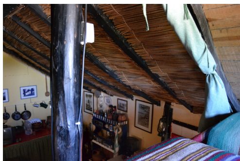
[50f]. Varas sobre o frechal embutido na parede exterior; construção 6.
