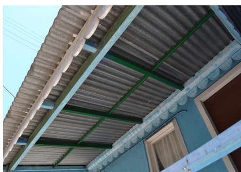
[86b]. Pormenor da cobertura da varanda; construção 1.
