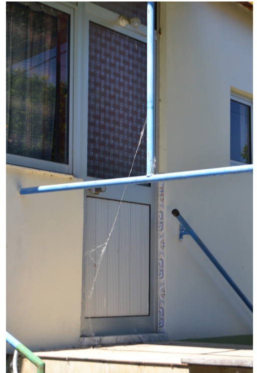
[97b]. Porta da varanda da construção 18.
