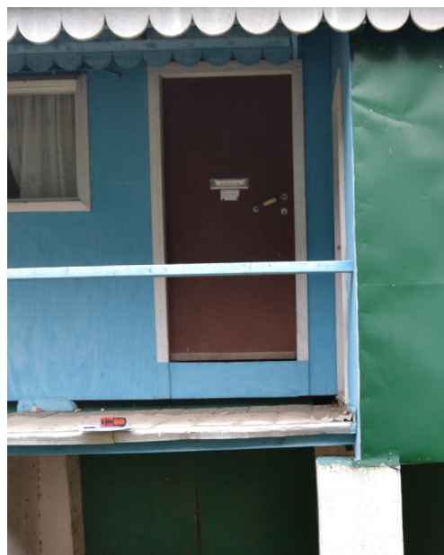
[94c]. Porta da construção 1.
