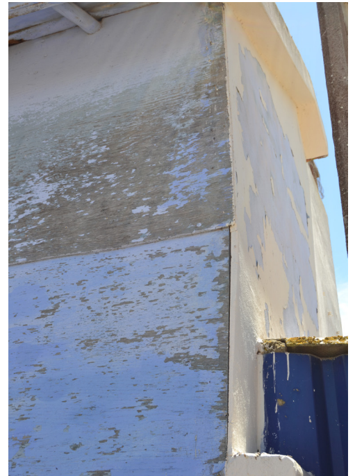
[45b]. Pormenor da espessura do reboco aplicado sobre o contraplacado; construção 2.
