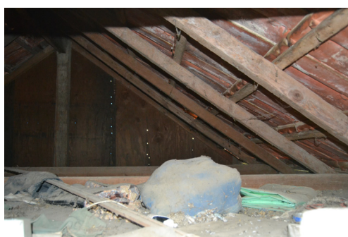
[50g]. Estrutura da cobertura da construção 5.
