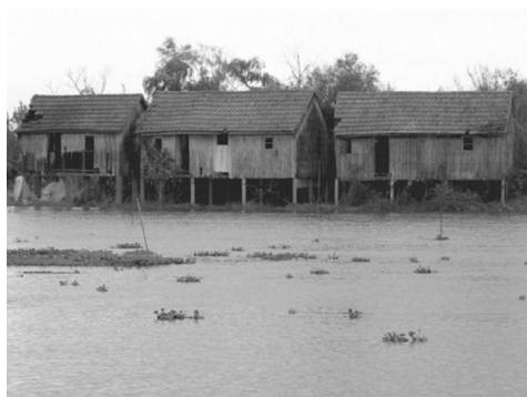
[10]. Patação de Cima.
