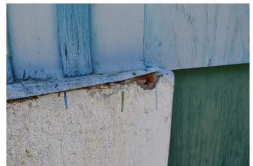
[88b]. Pormenor do tijolo cerâmico que compõe o pilar.
