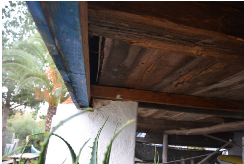
[65c]. Pormenor do encaixe da parede exterior com o pilar; construção 6.
