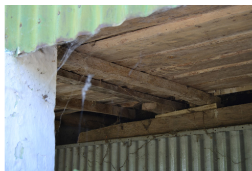
[32d]. O recurso a mais vigas para reforçar a estrutura e/ou nivelar o pavimento interior é comum na aldeia; esta fotografia corresponde à construção 22 no quadro em 3.1.1.
