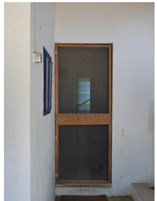
[98b]. Porta da construção 19.
