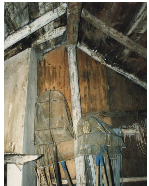
[34d]. Pormenor do prumo central, pau de fileira e lareira.
