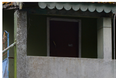
[94b]. Porta da construção 5.
