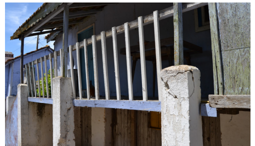
[29c]. Habitação 4 - pormenor da varanda e pilares.
