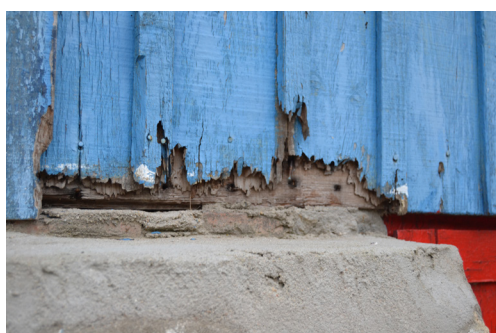
[43e]. Pormenor da parede Norte da construção 6.
