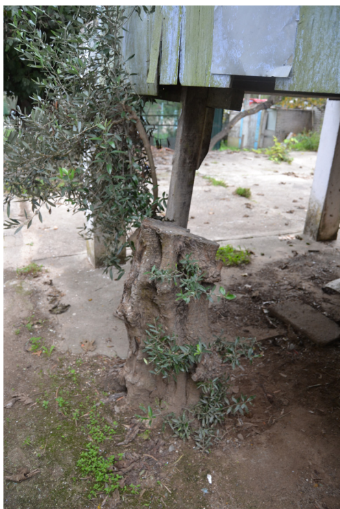
[93b]. Pormenor do tronco de árvore que seria usado para suportar a construção; habitação 5.
