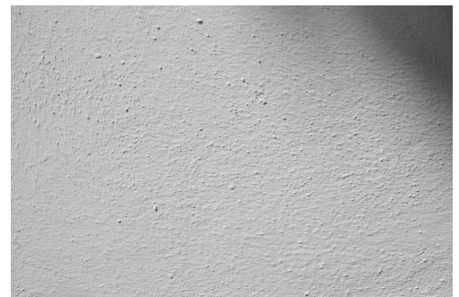
[46c]. Pormenor da textura da parede da construção 6; a superfície do revestimento é areada.
