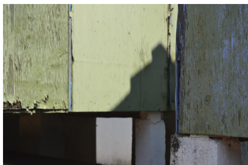
[44b]. Pormenor das juntas do contraplacado nos vértices das paredes.
