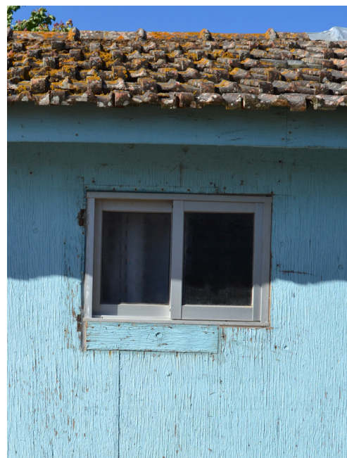
[101b]. Janela da construção 7.
