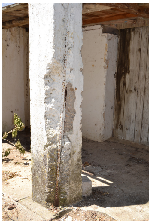
[89b]. Pilar da construção 4.
