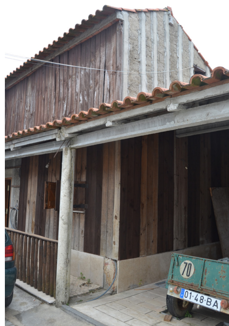
[3b]. Construção em alvenaria revestida a tabuado de madeira, Caneiras.
