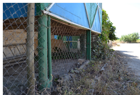
[91c]. Pormenor da construção 25 sobre pilares.
