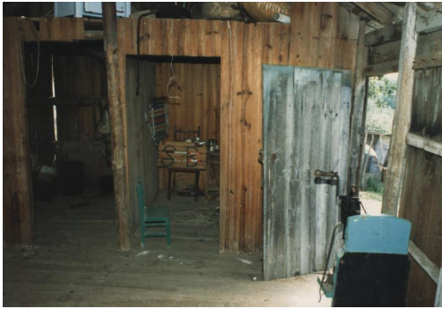
[65b]. Elementos de madeira (inclusive o pavimento) da construção 6.
