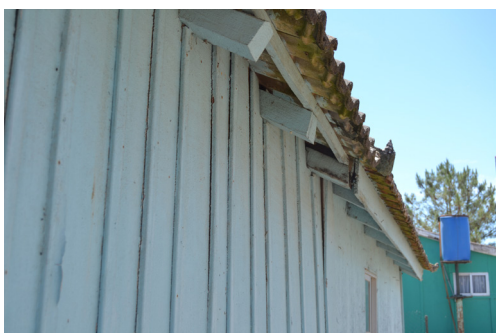
[57b]. Pormenor do beiral da construção 7.
