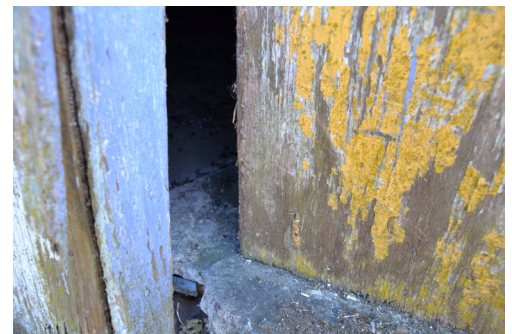
[67b]. Fotografia do pavimento do anexo 8.
