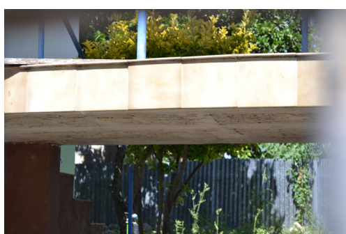
[72c]. Pormenor do pavimento da varanda da construção 18.
