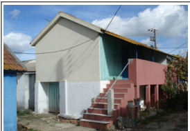
"Esta habitação mantém no geral a estrutura base destes edifícios, em madeira, revestida exteriormente por contraplacado com pintura, e cobertura em telha marselha. No entanto algumas das paredes foram posteriormente revestidas com reboco e pintura. O espaço designado por "adega" foi construído posteriormente em tabuado de madeira com pintura. Algumas paredes foram executadas a reboco e pintura. A chaminé foi eliminada ou, eventualmente, nunca foi construída. A tardoz foram construídos um conjunto de anexos, com ligação entre eles, para usos diversos. Estas construções são dissonantes do conceito padrão."
