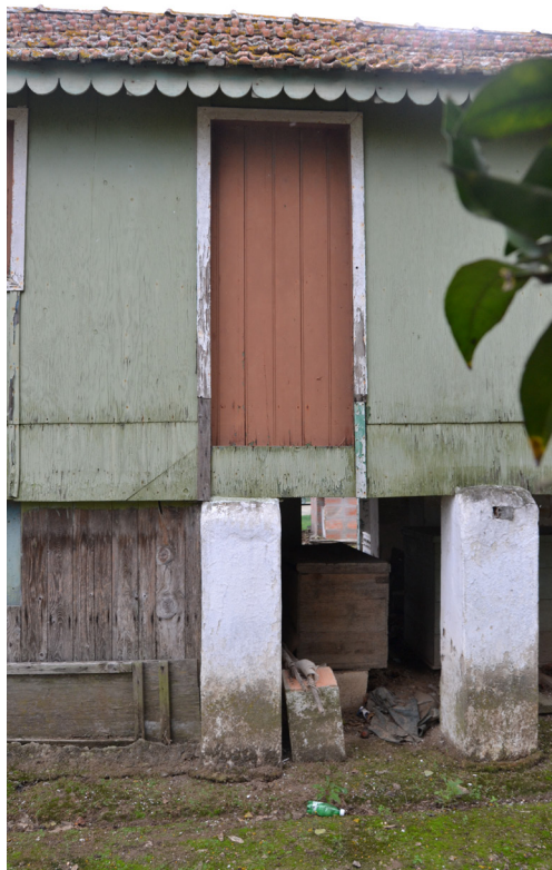
[95b]. Porta secundária da construção 5.
