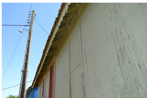
[56d]. Pormenor do beiral da construção 5.
