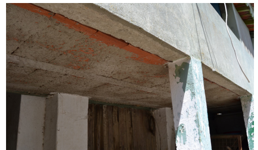
[71c]. Pormenor do pavimento da varanda da construção 5.
