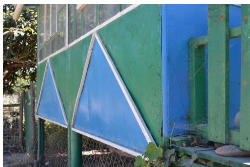
[36b]. Fotografia demonstrativa da estrutura; corresponde à construção 25 no quadro em 3.1.1.
