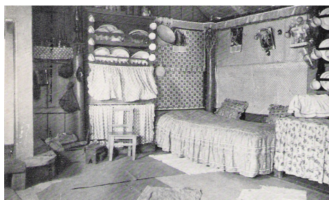
[23a]. Interior de uma habitação Avieira na Palhota (1964);
