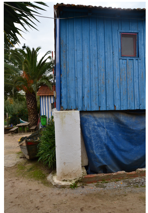
[43b]. Pormenor das paredes sobre o pilar; construção 6.
