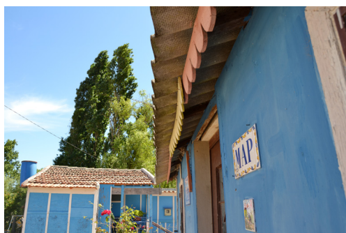
[61b]. Pormenor do beiral da construção 12.
