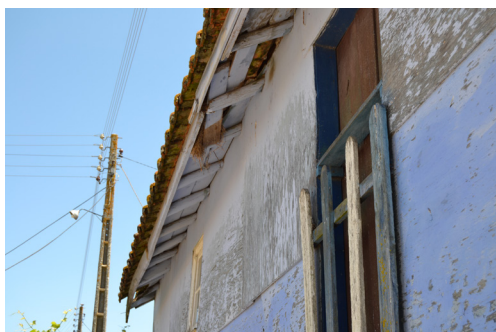
[56c]. Pormenor do beiral da construção 2.
