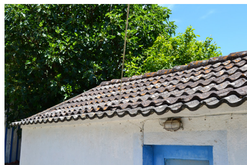
[55b]. As telhas de cimento do anexo 9.
