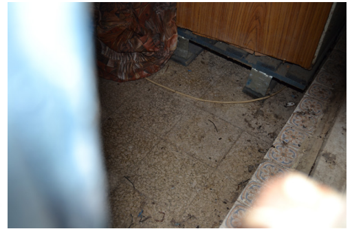
[66b]. Fotografia do pavimento do anexo 3.
