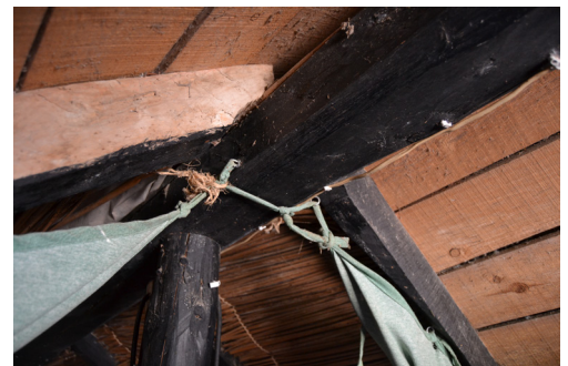
[50d]. Pormenor do encontro entre o pau de fileira, varas e prumo central; construção 6.
