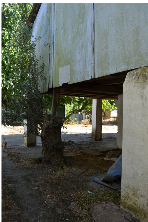
[93c]. Pormenor do tronco de árvore entre dois pilares.
