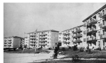
95. BAIRRO DO CERCO
