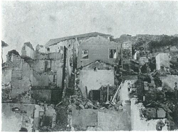
83. DEMOLIÇÕES NO CENTRO
