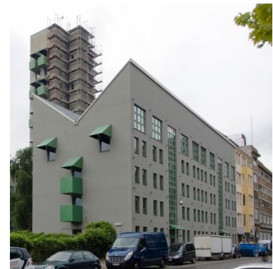
151.EDIFÍCIO RESIDENCIAL E COMERCIAL (HEJDUK)
