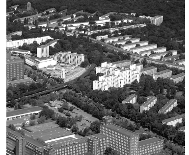
21. VISTA ÁREA | GROSSSIEDLUNG SIEMENSSTADT
