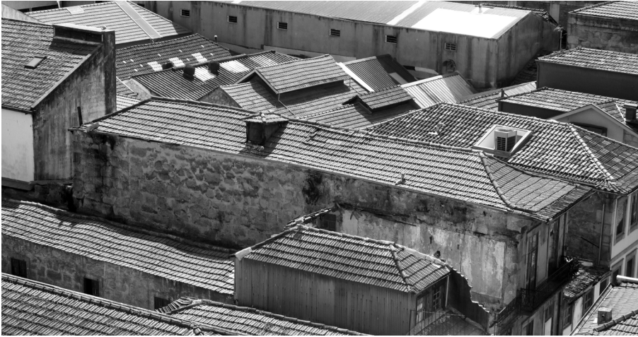
Fig. 53 Parede de meação Nascente
