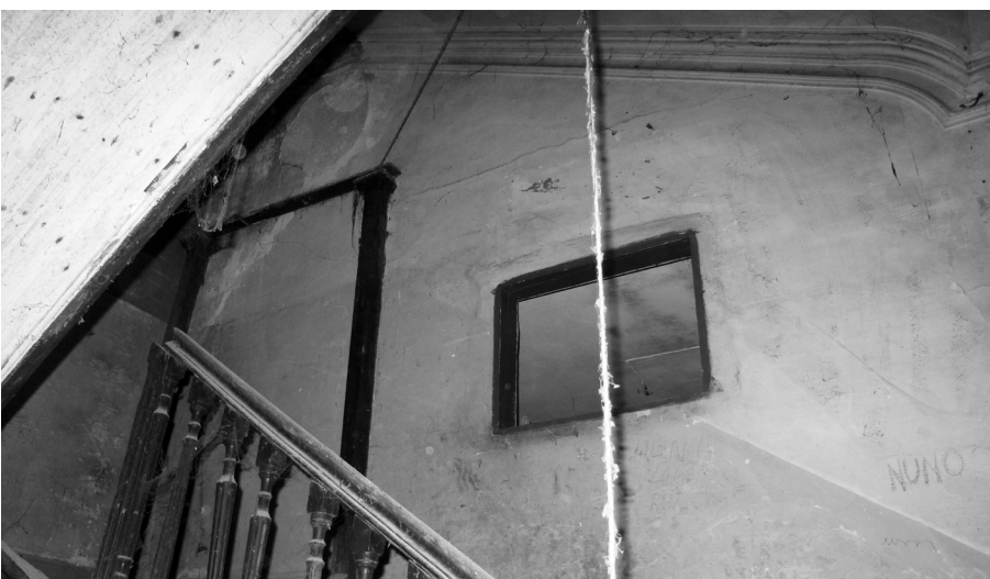
Fig. 82 Parede da caixa de escadas
