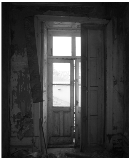
Fig. 97 Exterior da janela de sacada de batente
