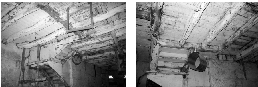
Fig. 65 e 66 Estrutura do 1º piso
