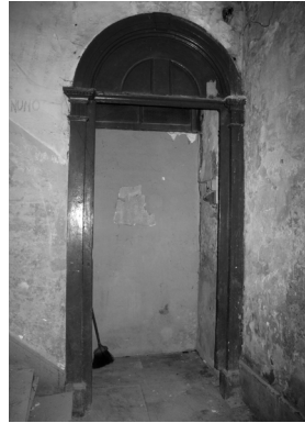
Fig. 29 Escada de acesso ao 1º piso
