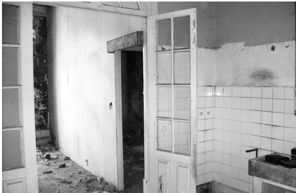
Fig. 44 Acesso ao fogo Norte do 2º piso
