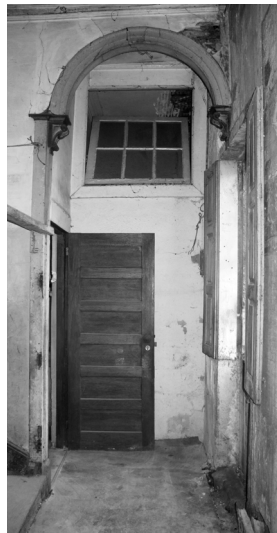
Fig. 107, 108 e 109 Arcos de entrada nos fogos
