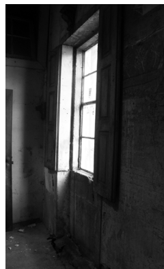
Fig. 102 Vão da antiga janela de guilhotina do 1º piso (tardoz)
