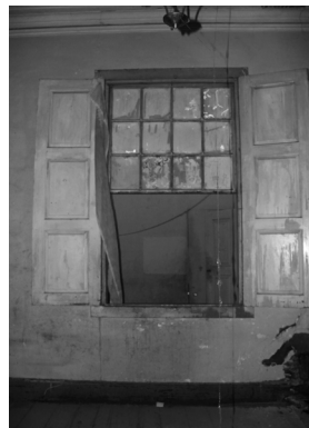
Fig. 46 Acesso ao fogo Sul do 2º piso
