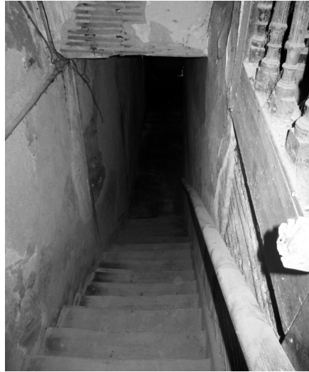
Fig. 83 Estrutura da escada de tiro
