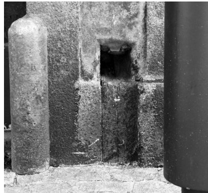
Fig. 69, 70 e 71 Beirado da cobertura e tubo de queda
