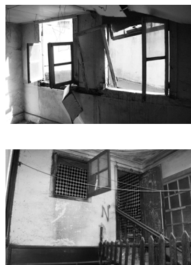
Fig. 49 Acesso aos anexos do 2º piso
