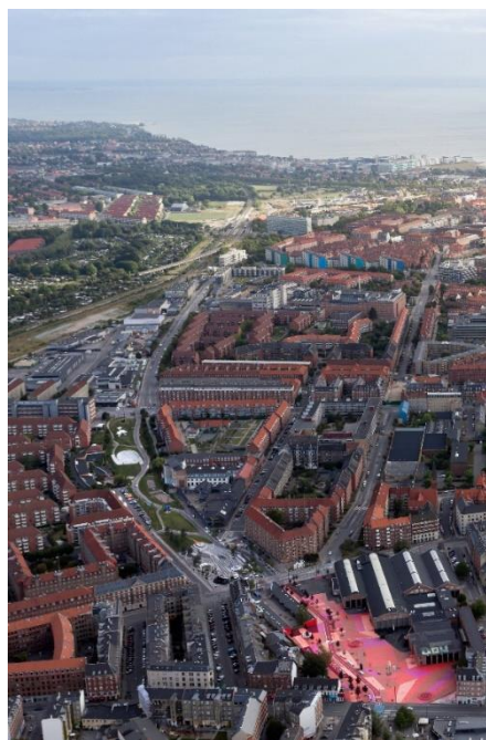
Fig. 10 - Fotografia aérea do projeto Superkilen. Fonte: www.superflex.net . Autor: Iwan Baan.
