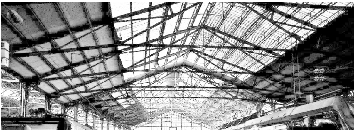
13. cobertura da estação ferroviária wLa Gare St Lazare, 1877
