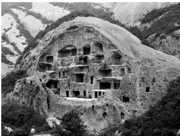
1. construção suprimida: “Guyaju”, China, séc. VII
