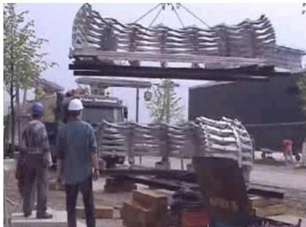
processo de montagem: Iris Dome , Exposição Internacional em Hanover, Alemanha, 2000, Chuck Hoberman
