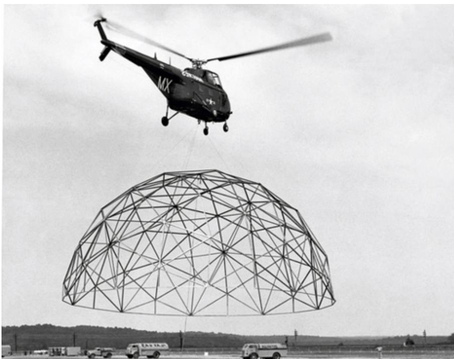
28. transporte da cúpula via aérea
