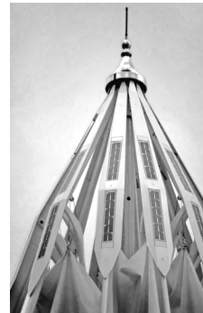
135. detalhe da cobertura, painéis FV.
