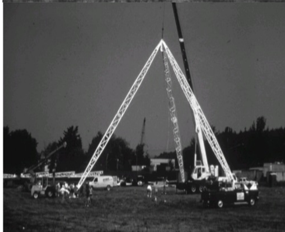
32. “Carlos Moseley Music Pavilion”, processo de montagem
