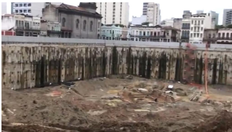
Fig. 4.5 - Preparação das fundações do edifício, com Igreja de Santo António dos Pobres (lado esquerdo) e bombagem de água do fundo da escavação (tubo de cor laranja, lado direito). (Chagas, 2009)
