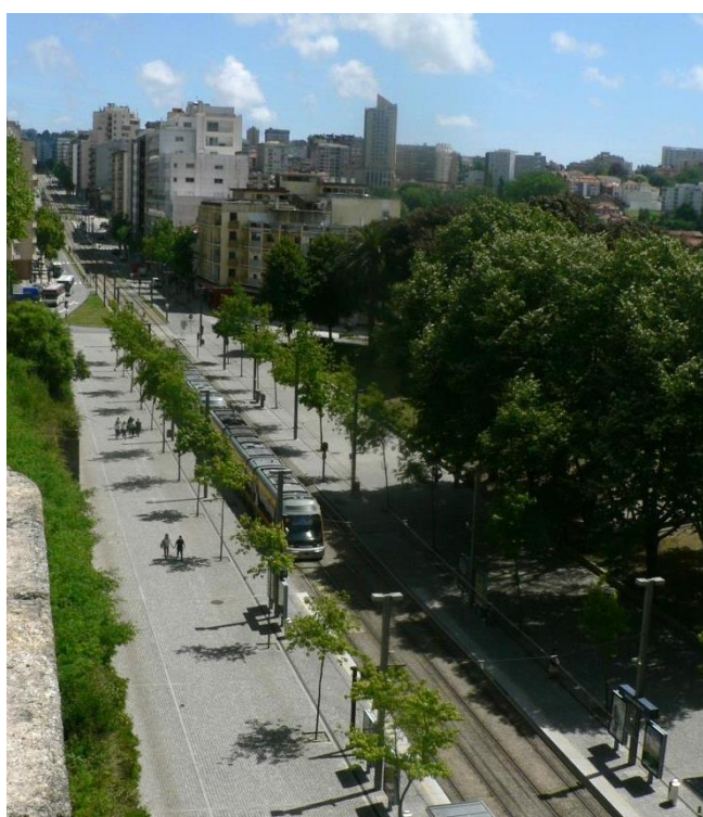
Figura 12 - Prolongamento da rede de metro pela Av. da República Fonte: Captação própria, Junho 2014
