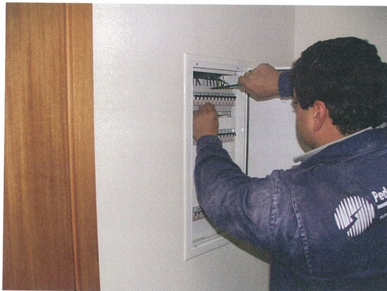
Figura 4.2 - Ligação de um quadro elétrico
