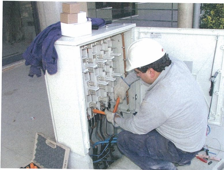
Figura 4.1 - Ligação de um armário de distribuição
