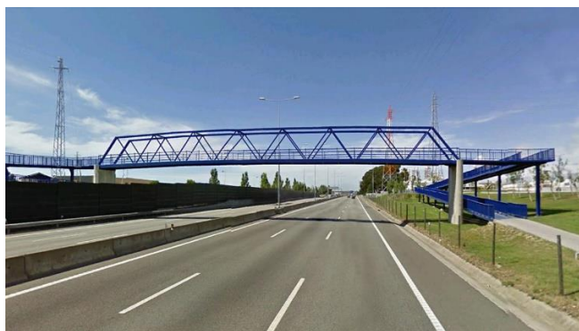
Figura 4.7 - Exemplo de travessia pedonal superior
