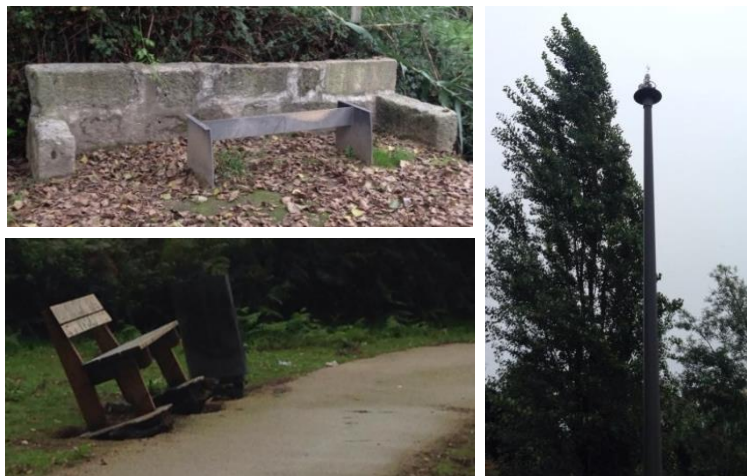
Figura 25 – Resultados de atos de vandalismo em bancos e postes de iluminação no troço do Viso da Ribeira da Granja (15/10/13).
