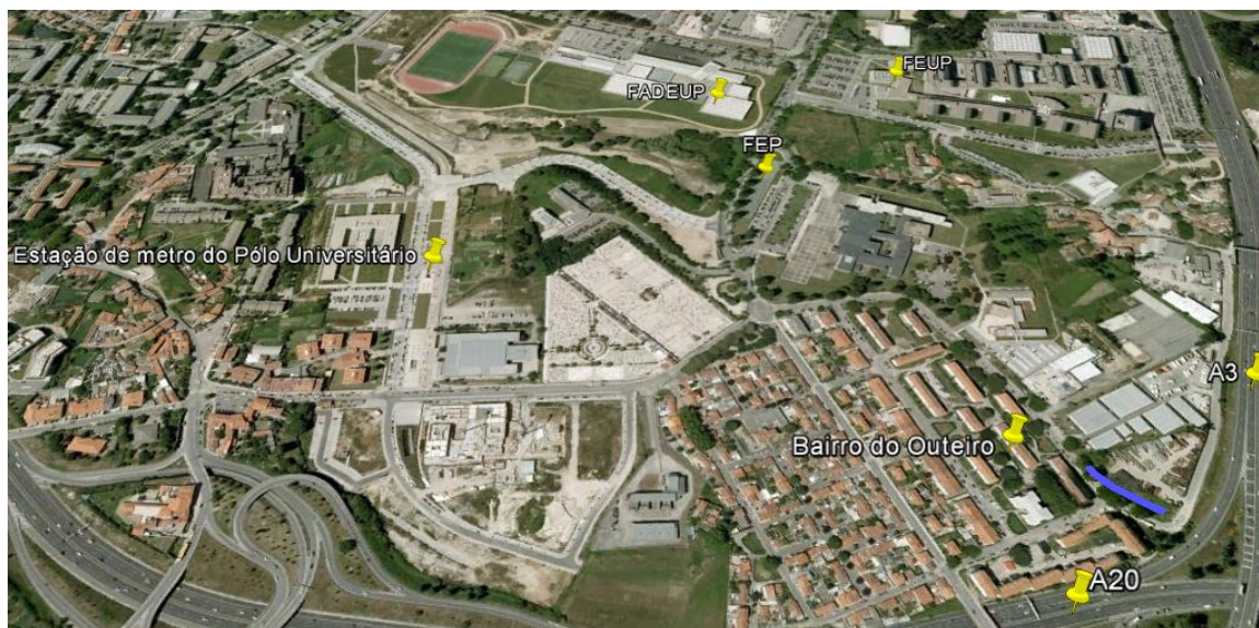
Figura 11 - Fotografia aérea do troço intervencionado da ribeira da Asprela (sinalizado a azul) e da envolvente (google earth, 2007).
