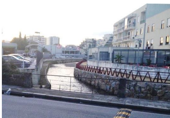
Figura 44 – Situação pós-intervenção na zona mais a jusante do sub-troço 3 (29/10/13).
