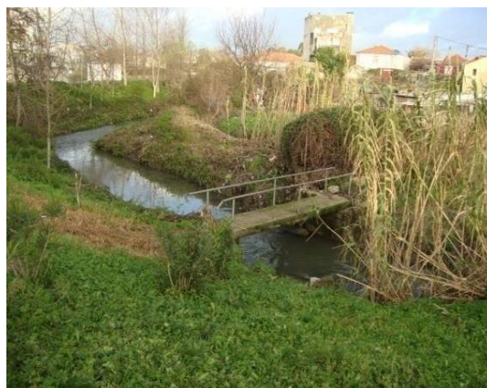
Figura 7 – Situação pré-intervenção da ribeira da Granja no troço do Viso (cedido pela AdP).
