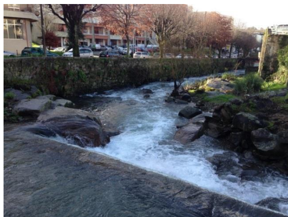
Figura 41 – Leito do rio constituído por maciço rochoso, a proteger, no sub-troço 3 (13/01/14).
