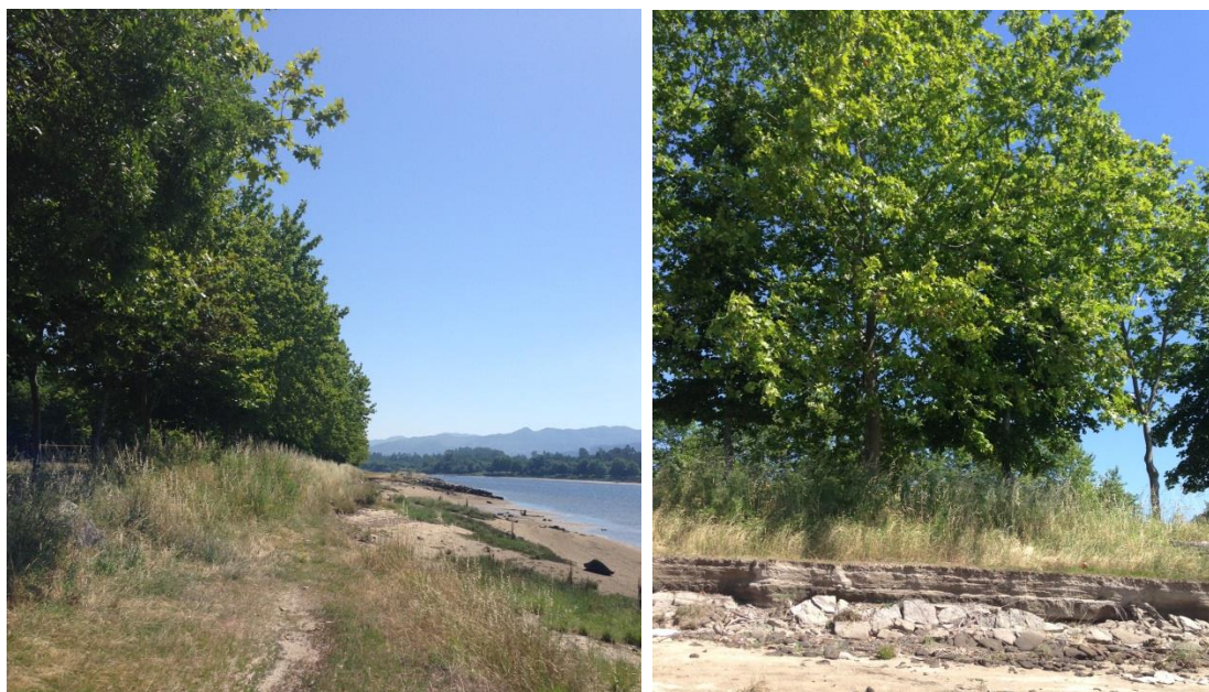
Figura 76 – Erosão da margem direita do rio Lima, pondo em risco uma linha de árvores de grande porte, no troço de Cardielos onde apenas foram instalados esporões (13/06/14).
