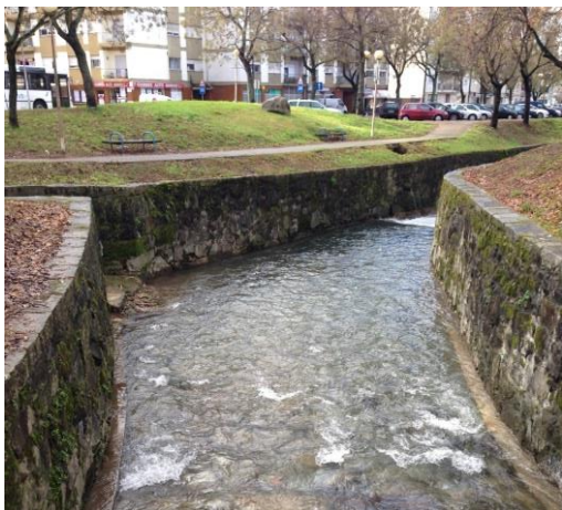
Figura 38 – Zona do Parque da Ponte, que não sofreu intervenção para melhoria das condições hidráulicas (13/01/14).
