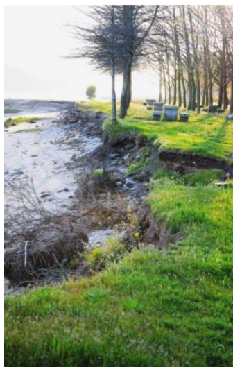
Figura 66 – Situação pré-intervenção de instabilidade da margem direita do rio Lima no troço de Cardielos (cedido pela CmV).
