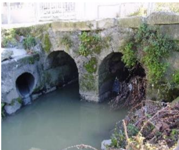
Figura 9 – Passagem hidráulica da Travessa de Requesende (cedido pela AdP).
