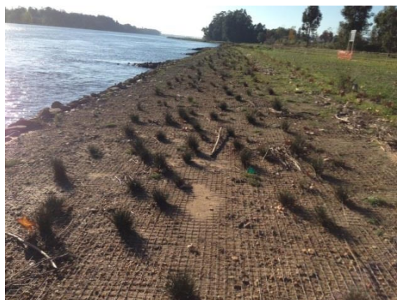
Figura 79 – Rede de malha metálica de proteção da camada de terra vegetal visível no troço de Cardielos (14/11/13).
