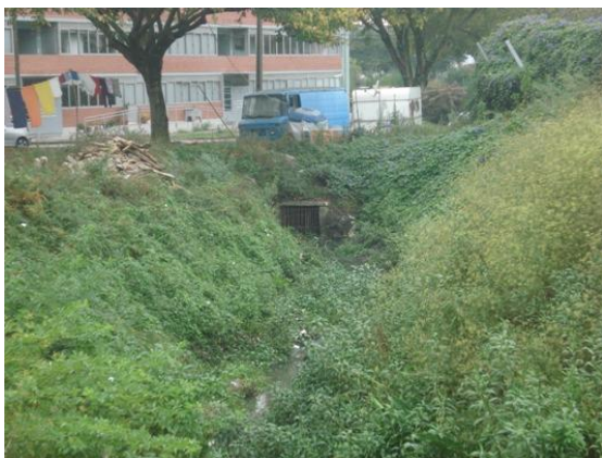
Figura 12 - Situação pré-intervenção do troço do Outeiro da ribeira da Asprela (cedido pela AdP).
