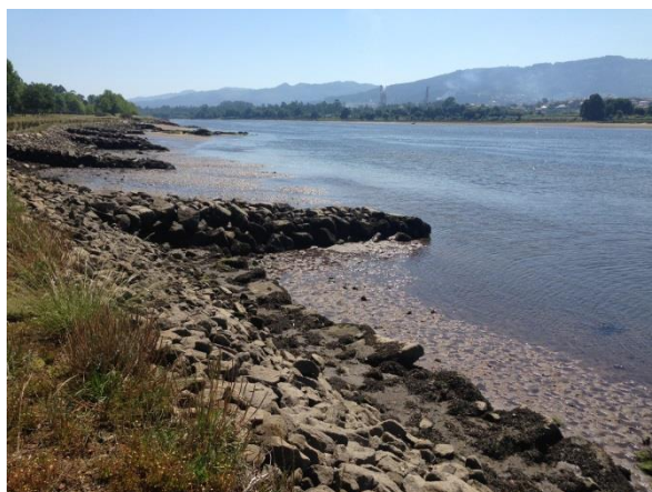
Figura 74 – Deposição de sedimentos nas zonas localizadas entre os esporões e defletores instalados no setor de Cardielos (13/06/14).
