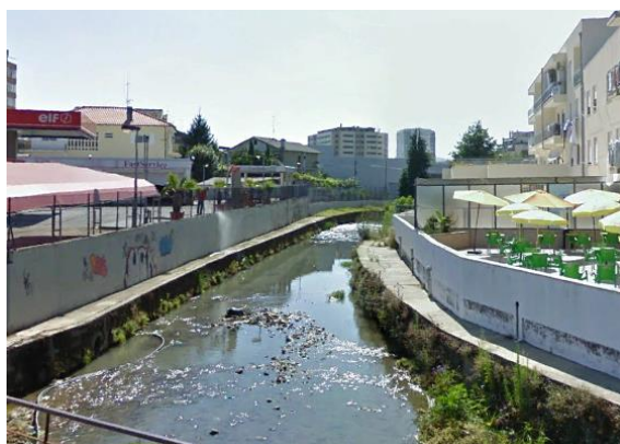
Figura 43 – Situação pré-intervenção na zona mais a jusante do sub-troço 3 (google earth, 2009).
