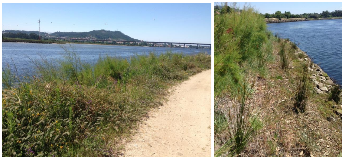
Figura 88 – Estado da vegetação aplicada no troço de Portuzelo, em junho de 2014 (13/06/14).
