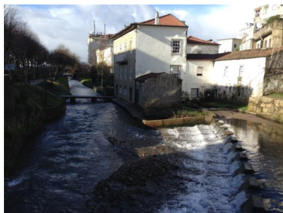
Figura 40 – Levadas da Zona dos Galos, no sub-troço 3, sujeitas a limpeza e desobstrução (13/01/14).
