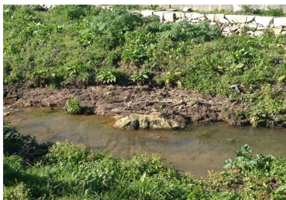
Figura 29 – Margens sujeitas a erosão no troço da Quinta do Rio da ribeira da Granja (23/02/14).
