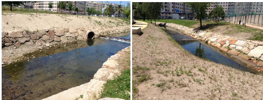
Figura 54 – Zonas do sub-troço 5 onde a sementeira não desenvolveu (13/06/14).
