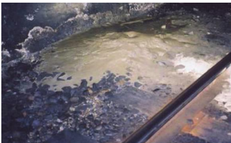
Figura 9 - Bombagem de finos (Indraratna et al. , 2011).
