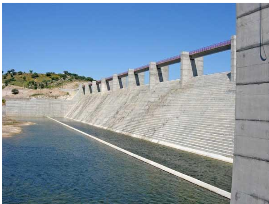
Figura 2.20 - Barragem de Pedrógão (PERI)
