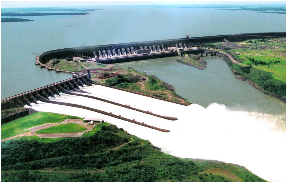
Figura 2.15 - Barragem de Itaipu-PR, Brasil ( www.damengineer.com ).
