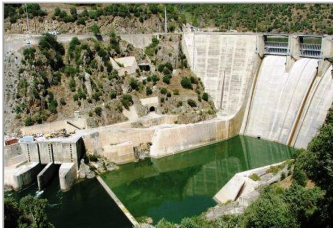
Figura 2.6 - Barragem de Bemposta (Portugal).
