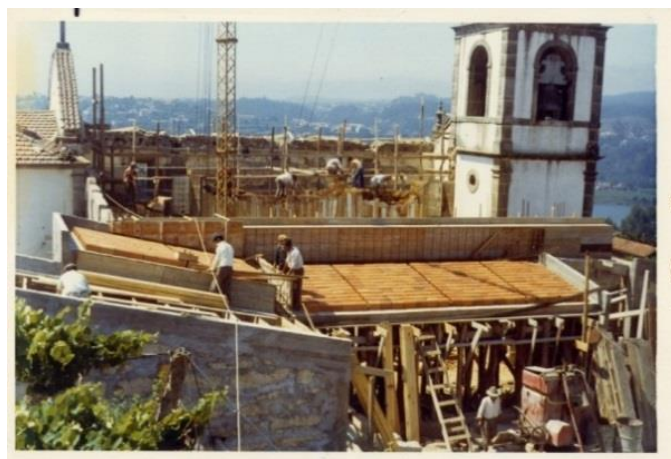
Ilustração 3: Obras efetuadas entre 1972 e 1984 para alargamento do espaço religioso. Arquivo da Igreja Matriz
