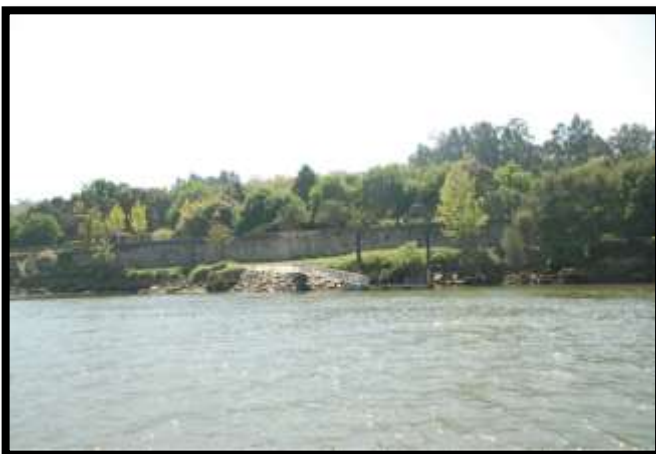
Figura 17 – Frente da Quinta da Torre Bella. Troço 1. Fonte: CM Gaia
