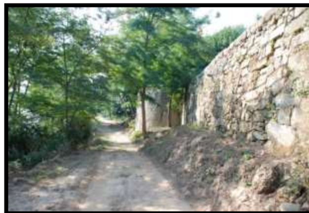
Figura 12 – Muros de granito da Quinta Fonte da Vinha. Fonte: CM Gaia
