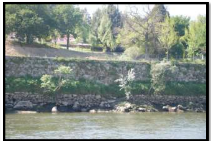
Figura 18 – Frente da Quinta da Torre Bella. Troço 2. Fonte: CM Gaia
