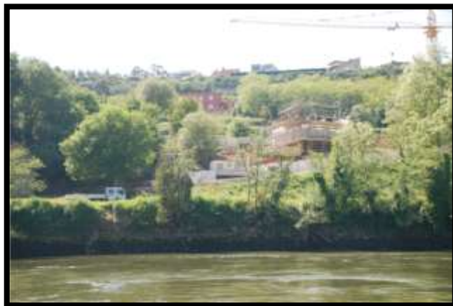
Figura 21 – Frente da área da Quinta dos Cubos. Troço 5. Fonte: CM Gaia
