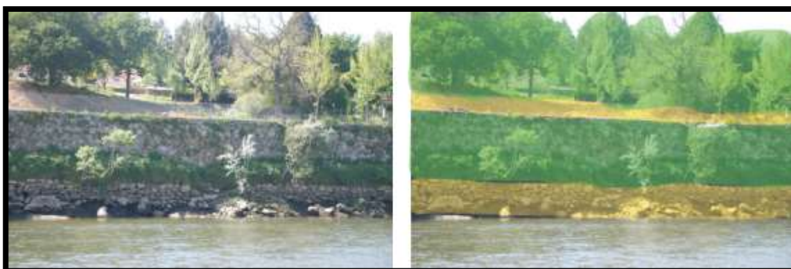
Figura 24 – Frente da Quinta da Torre Bella. Troço 2. Fonte: CM Gaia
