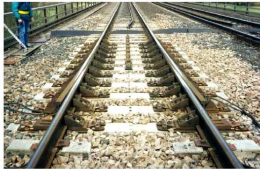
Figura 2.8 – Aparelho de dilatação de via.
