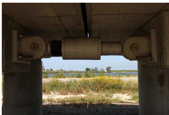
Figura 4.10 – Ligador hidráulico.
