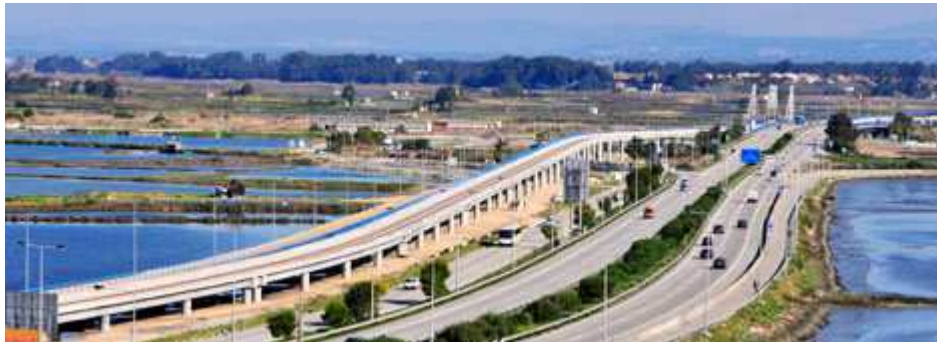
Figura 4.4 – Trecho do viaduto Poente de acesso à ponte das Pirâmides (REFER, 2010).
