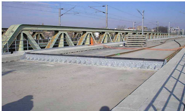
Figura 2.23 – Aparelho de retenção de balastro (Ramondenc et al. , 2007).
