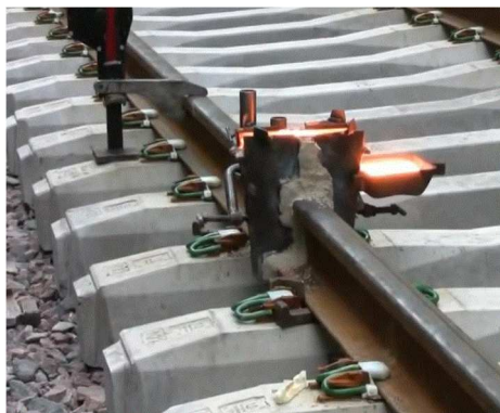
Figura 2.27 – Fase inicial do processo de soldadura aluminotérmica do carril.
