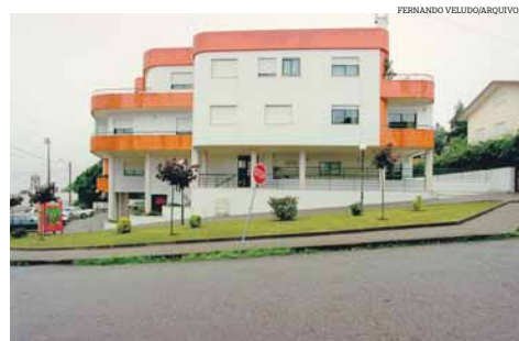
No terceiro piso do edifício moram quatro famílias
