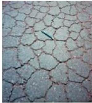
Fig.2.5 - Fendilhamento tipo “pele de crocodilo” [13]
