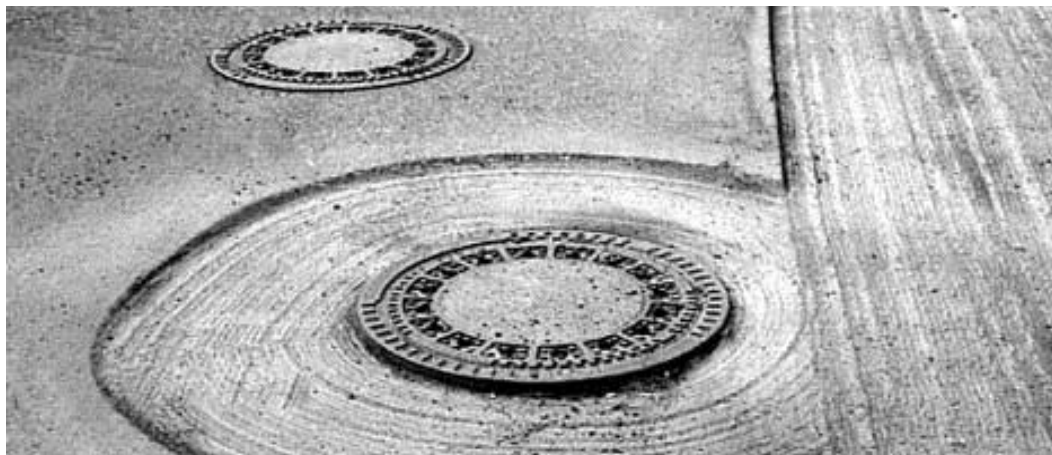
Fig.3.5 – Execução da fresagem de remates [22]
