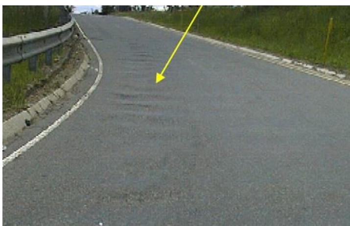
Fig.2.7 - Ondulações da superfície [13]
