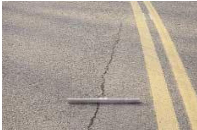
Fig.2.3 - Fenda longitudinal [13]
