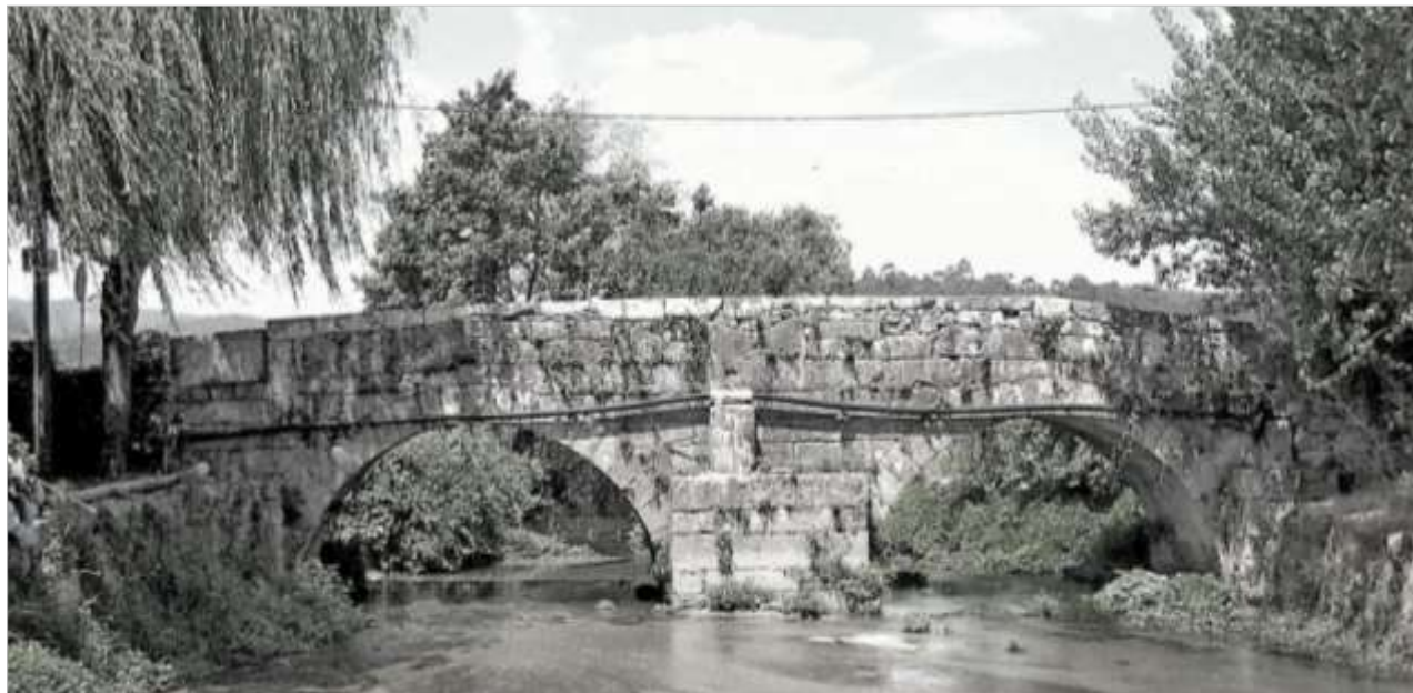
Fig.1. Paramento a jusante.
