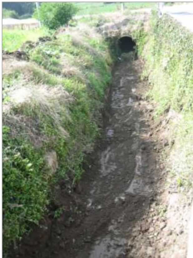
Fig.32. Primeiro troço do canal sem registos.
