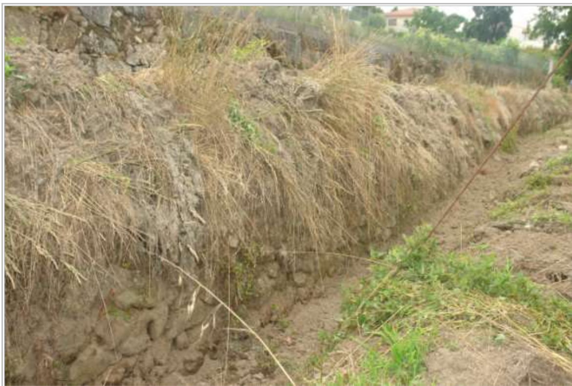
Fig. 73. O muro interior do canal em alvenaria de granito, nas testeiras das propriedades
