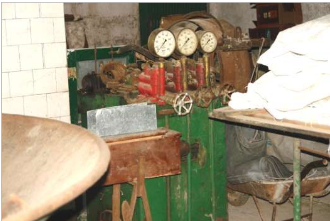
Fig. 36. Bomba de pressão das três prensas.
