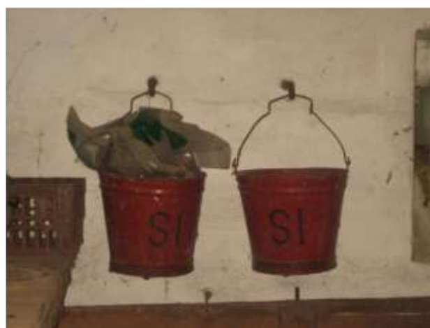
Fig. 23. Sistema de prevenção de incêndios obrigatório com a instalação das moendas elétricas
