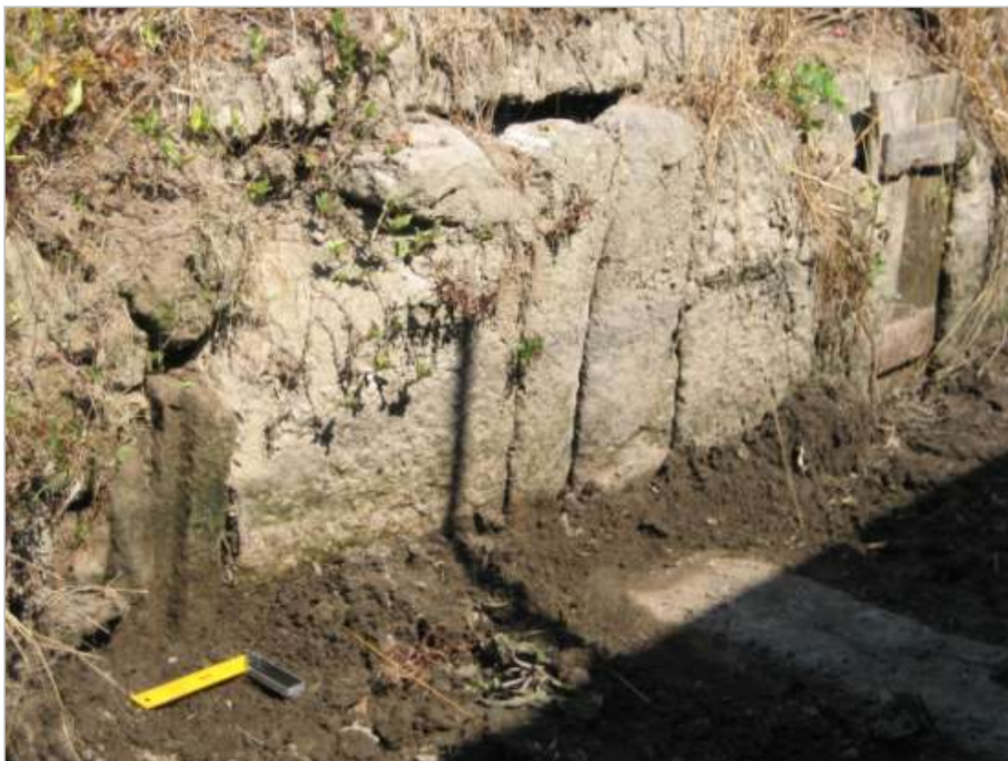
Fig. 70. Pilar da comporta, registo, talheiro de rega e soleira
