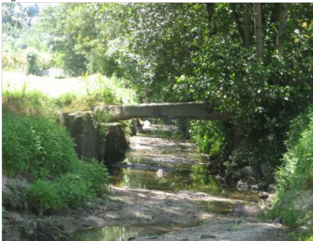
Fig.24. Boca do Canal mestre
