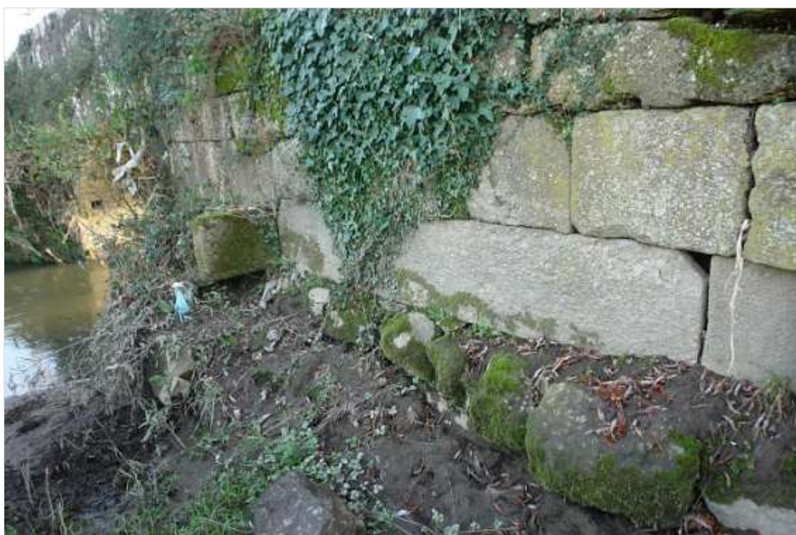
Fig.10. Arranque. Margem direita.
