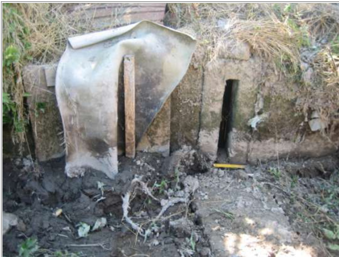
Fig. 15. Talheiro de rega hermeticamente fechado
