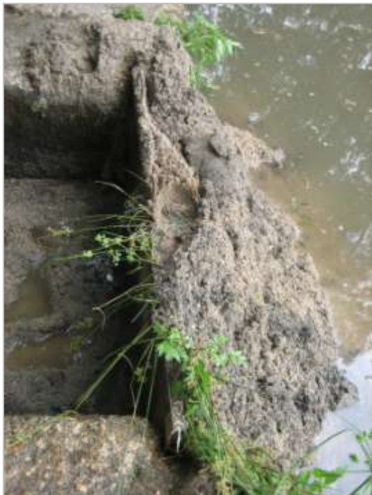
Fig. 29. Calafetagem com terra e vegetação.
