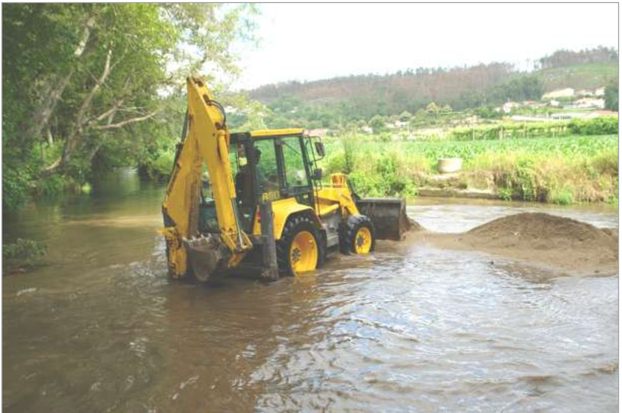
Fig. 17. Limpeza do açude
