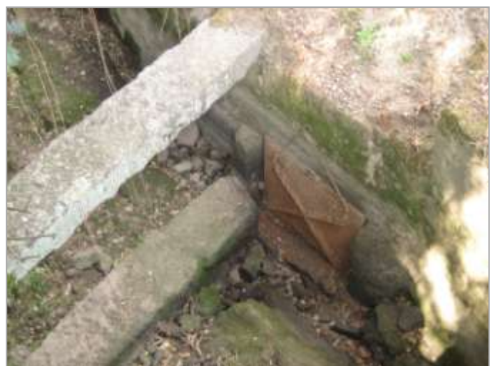
Fig.21. Comporta hermeticamente fechada com terra e vegetação
