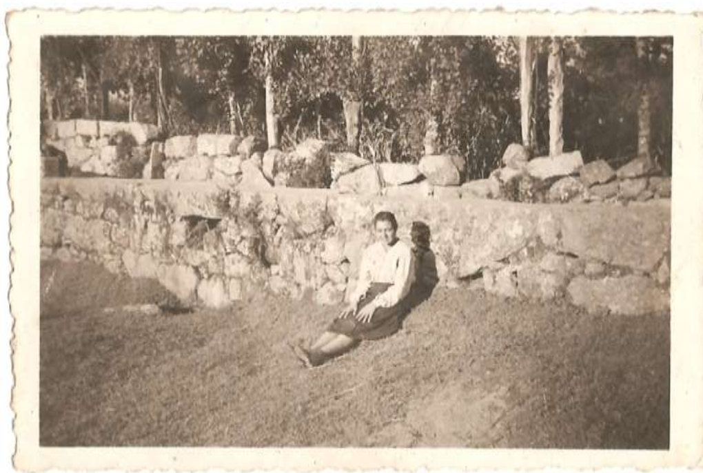
Fig.5. Antigo caminho de acesso à ponte de Coura, na margem esquerda. Anos 50 do séc. XX 175 . No muro é visível um aguadeiro de escoamento das águas residuais do regadio para o rio.
