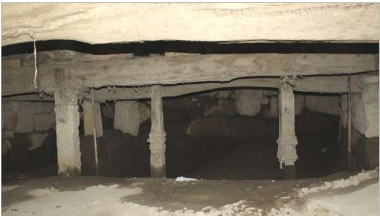
Fig.11. Inferno aterrado pelas inundações do rio, quase ao nível do travejamento do soalho.
