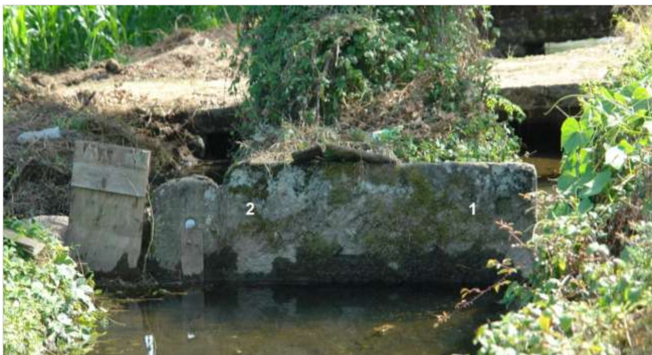
Fig.50. Fecho do canal na margem direita.
