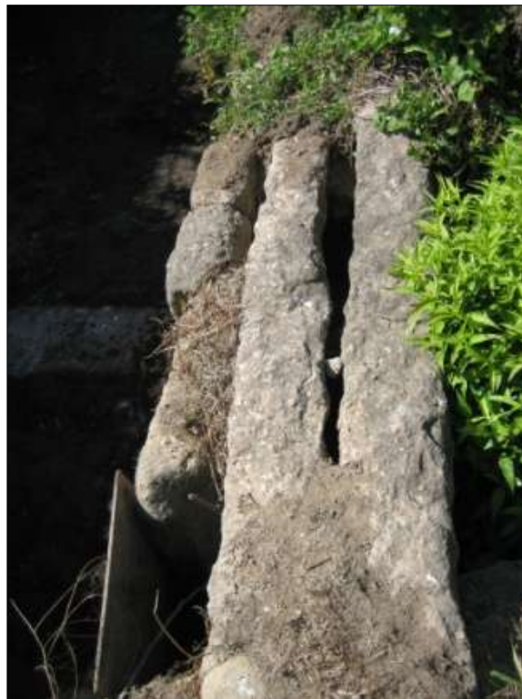
Fig. 60. Dois esteios de granito na cobertura reforçam e dão estabilidade à estrutura
