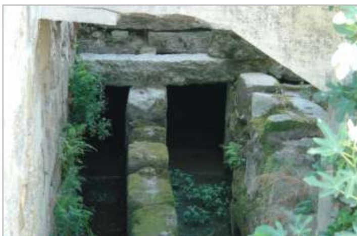
Fig. 4. Golas de duas rodas verticais, sob o passadiço
