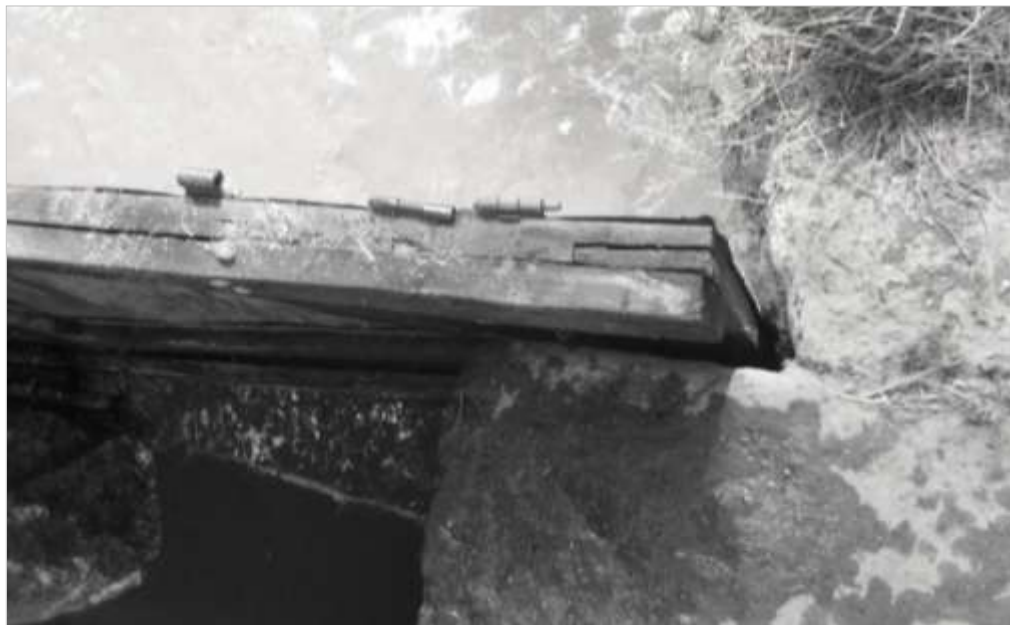
Fig. 28. Boca do canal mestre. Batente da comporta para fecho do canal.
