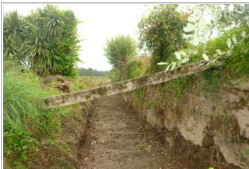
Fig.104. Canal em cimento de transporte de água sobre as margens do canal mestre
