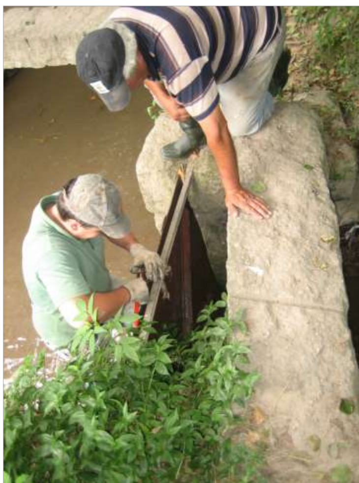
Fig.11. Fixação da comporta
