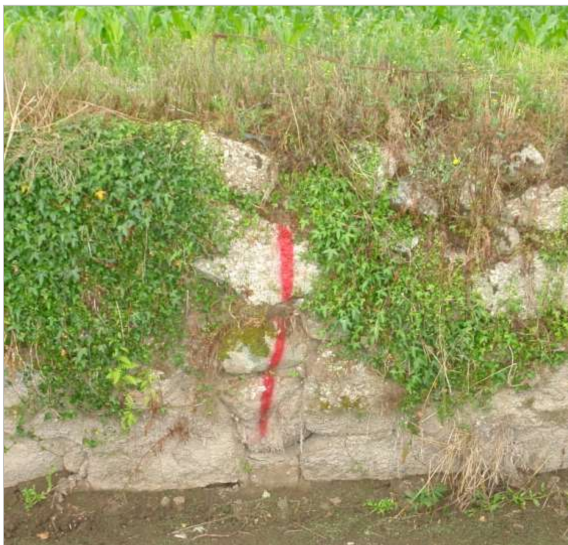
Fig. 109. Marcação da sorte de limpeza no muro externo do canal mestre
