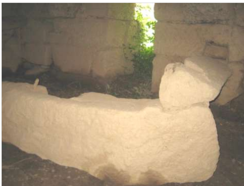
Fig.7. Pedra da gola da entrosga da moenda desmontada, junto ao alçado norte
