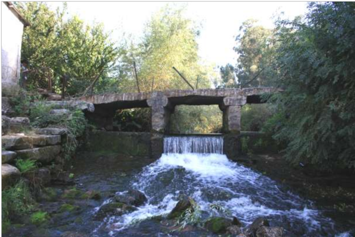
Fig.7. Açude a jusante
