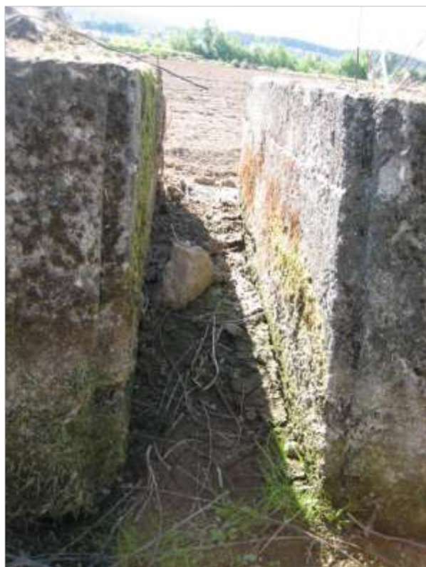
Fig. 144 e 145. Registo rasgado no muro de cimento.
