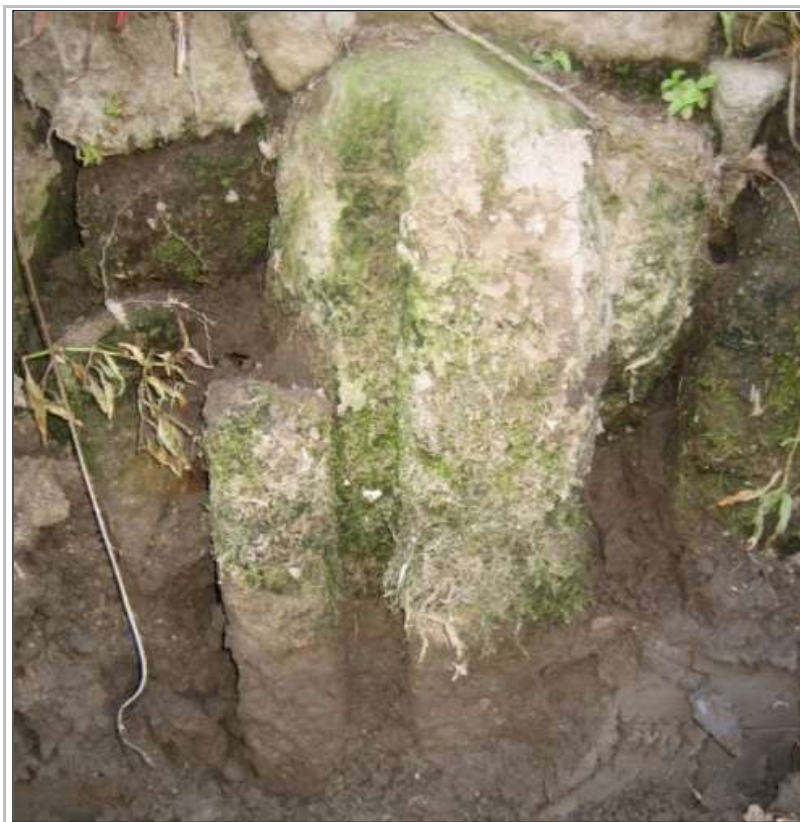
Fig.68. Pilar de comporta do canal mestre
