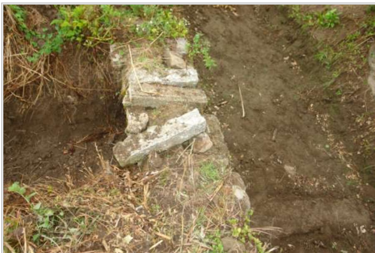
Fig. 106. Soleira e rego de condução da água aos terrenos
