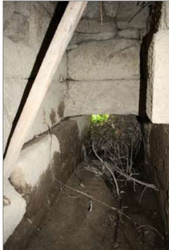
Fig. 10. Canal interior de condução da água à roda vertical
