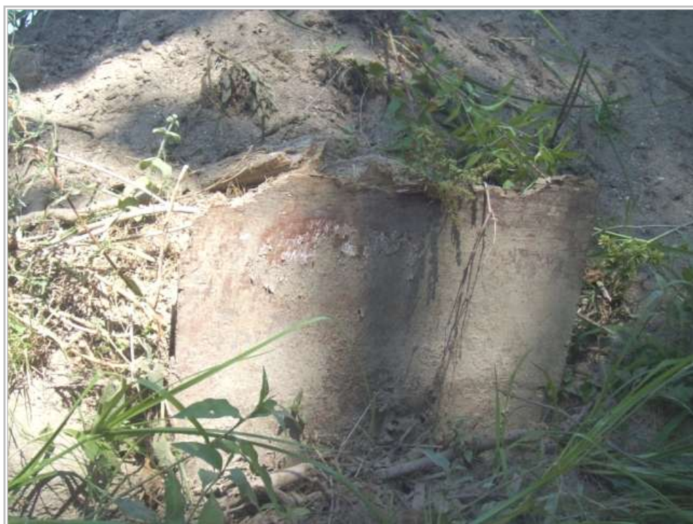
Fig.83. Prancheta de madeira regula o caudal admitido à parcela interior
