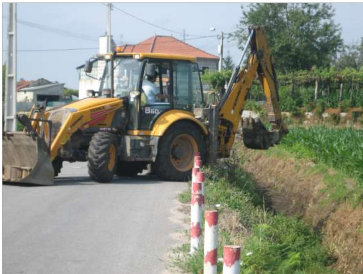
Fig. 31. Limpeza do primeiro troço do canal da margem direita. Lugar da Borralheira, Nine
