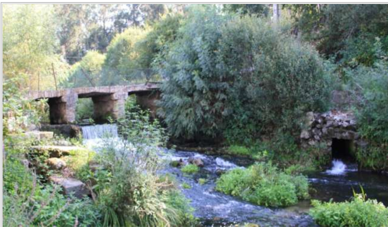
Fig.40. Saída do sangradouro para o rio a jusante do açude da azenha da Borrallheira
