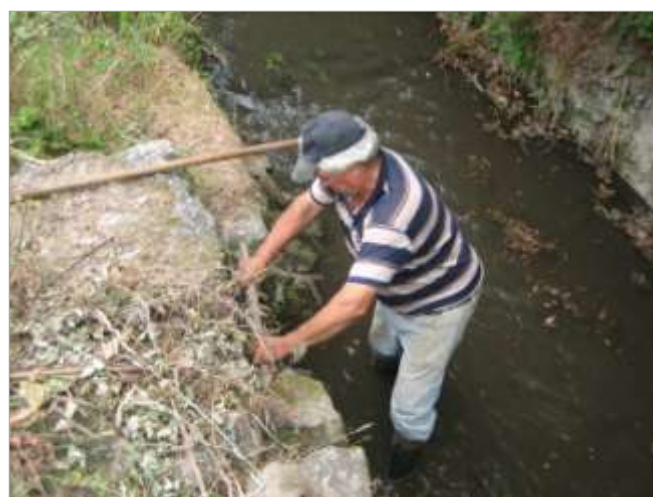
Fig.35 e 36. Início das regas. Remoção dos entulhos e areias trazidos pelas primeiras águas. Introdução da comporta para fecho do canal.
