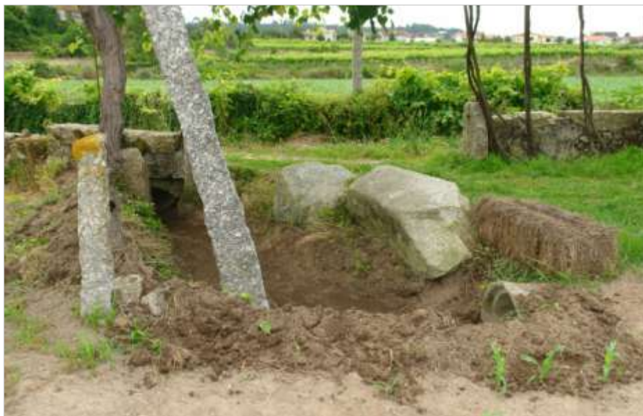
Fig. 78 Poça de derivação da água para os terrenos interiores. Lugar da Enxurreira. Níve
