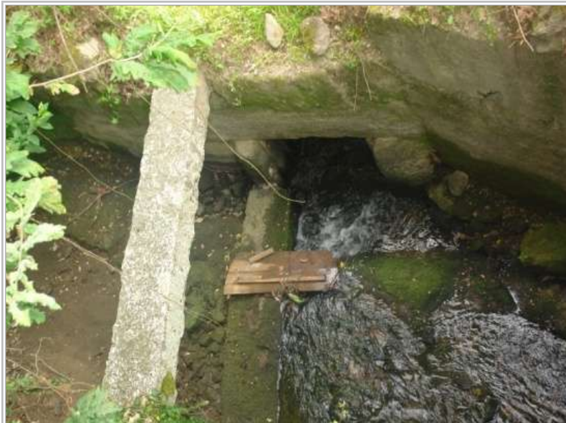
Fig.38. Derivação das águas para o sangradouro.
