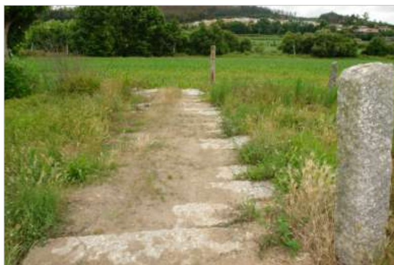
Fig.9. Canal soterrado sob lajes de granito.
