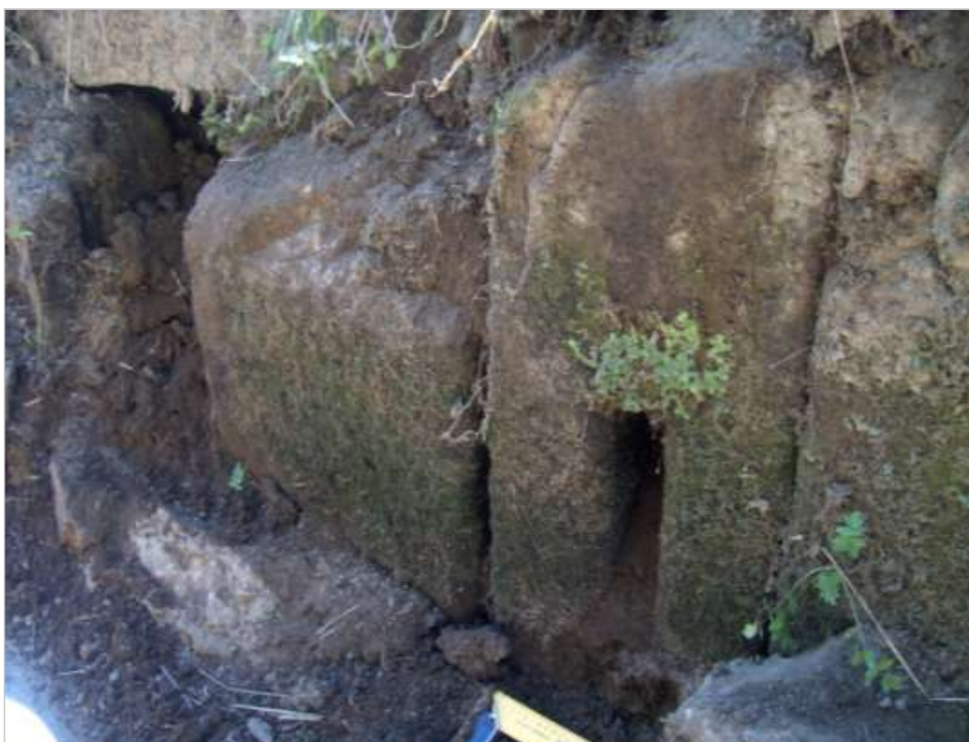
Fig.4. Derrube do murete do canal.
