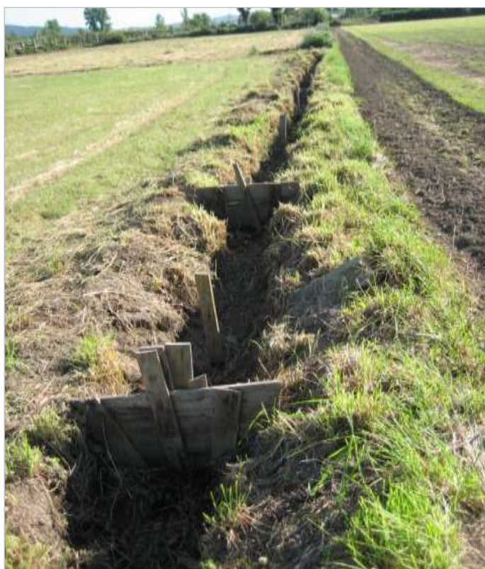
Fig.25. Canal interior com portinholas de madeira para derivação da água para o interior das parcelas
