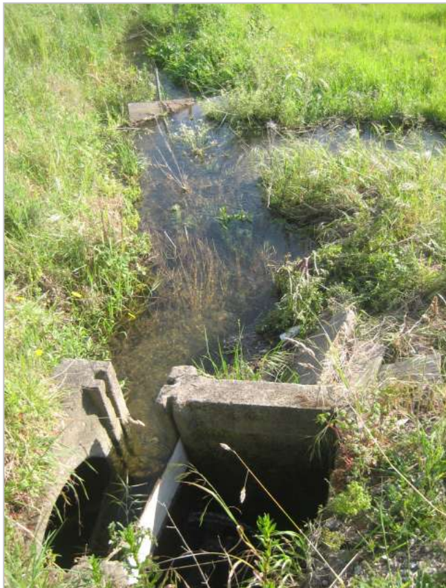
Fig.156. Moderna cisterna de derivação e registo.
