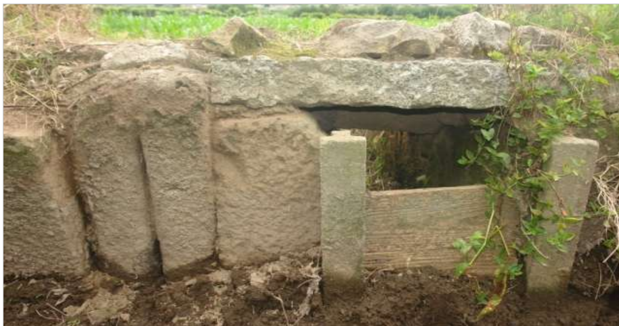
Fig.62. Talheiro de rega restaurado com vigas de cimento para suporte da comporta
