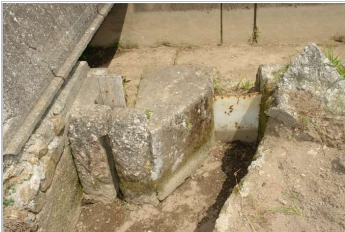
Fig. 120. Murete de betão que faz a ligação entre o registo granítico e o canal mestre
