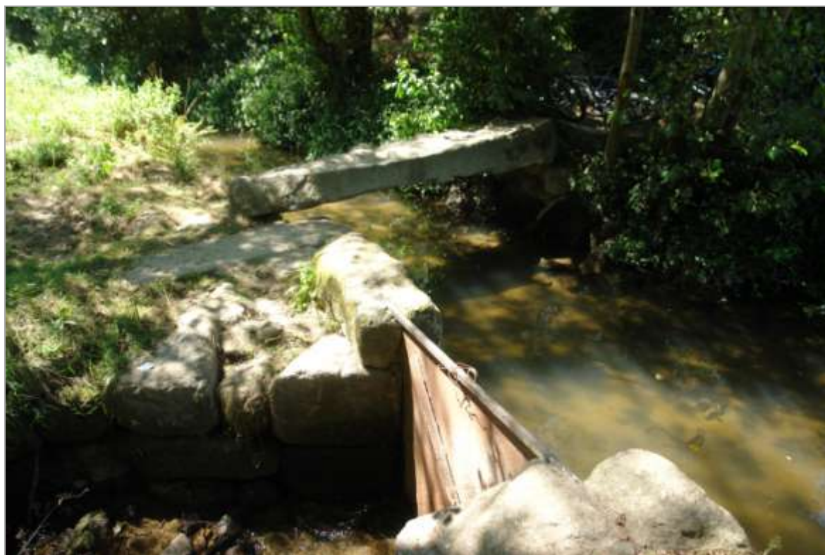
Fig. 25. Boca do canal e sangradouro do açude
