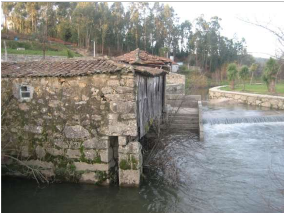
Fig.2. Área sobradada da serra. Alçado nascente
