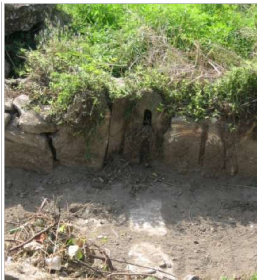
Fig. 36. Soleira e rasgo para a comporta do canal.
