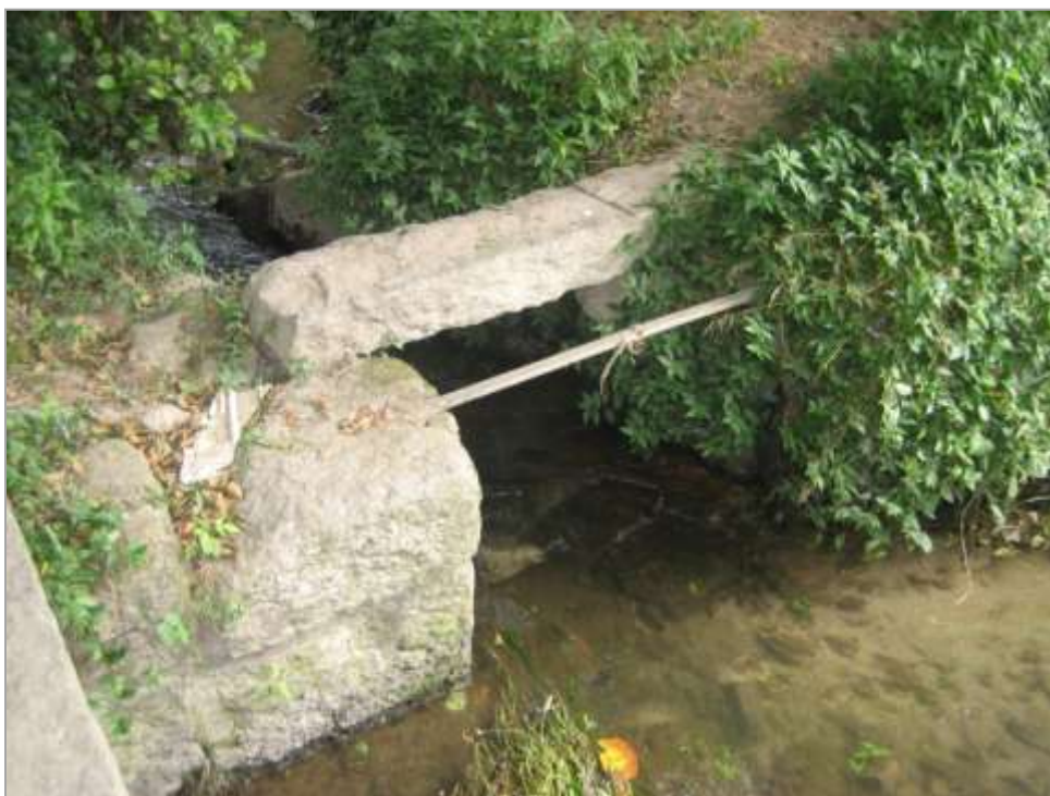
Fig.10. Sangradouro da margem esquerda
