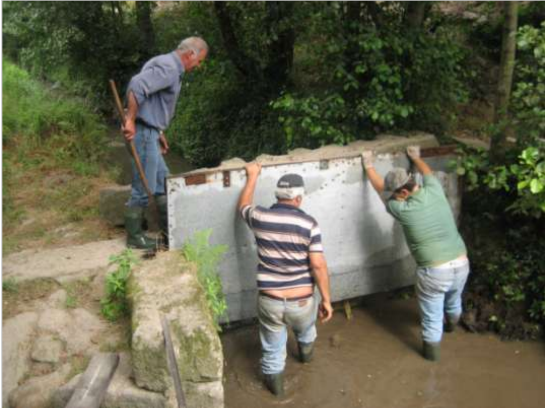
Fig. 27. Colocação da comporta para fecho do canal
