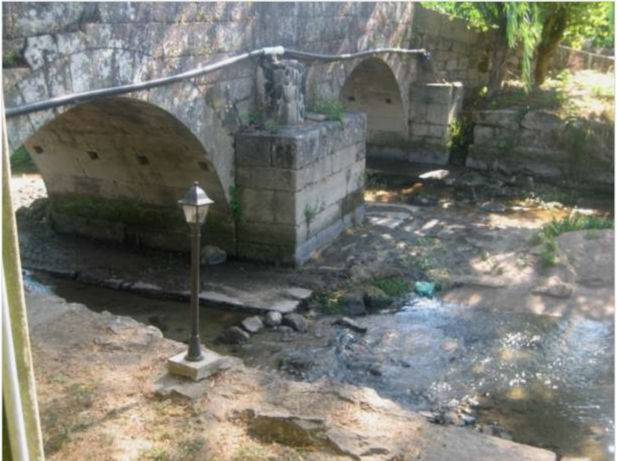
Fig. 3. Sapata no leito do rio. Verão 2013
