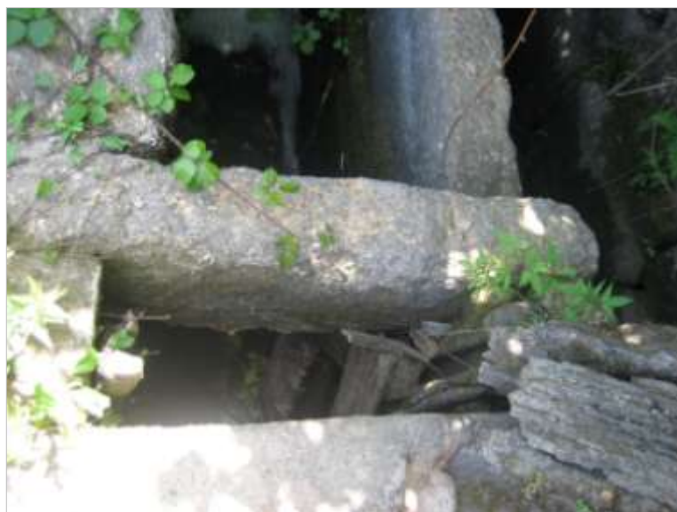
Fig.5. Encaixe da entosta em granito e madeira
