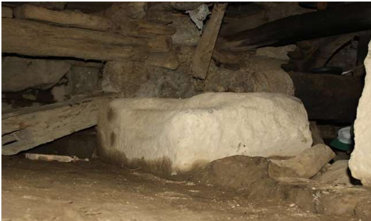
Fig.12. Canal e pedra de pouso do eixo da antiga roda vertical da serra de madeira
