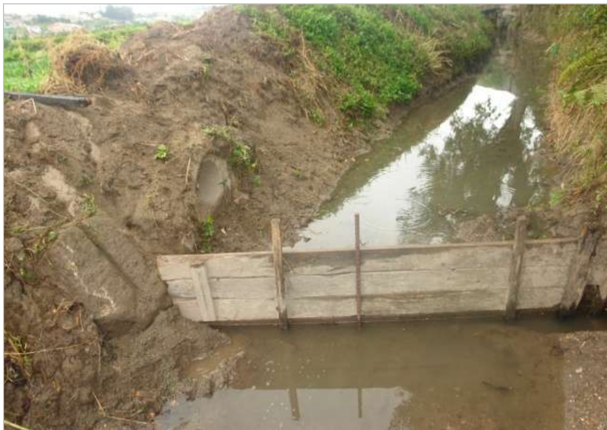
Fig. 84. Comporta de madeira no leito do rio, deriva a água para a boca do registo
