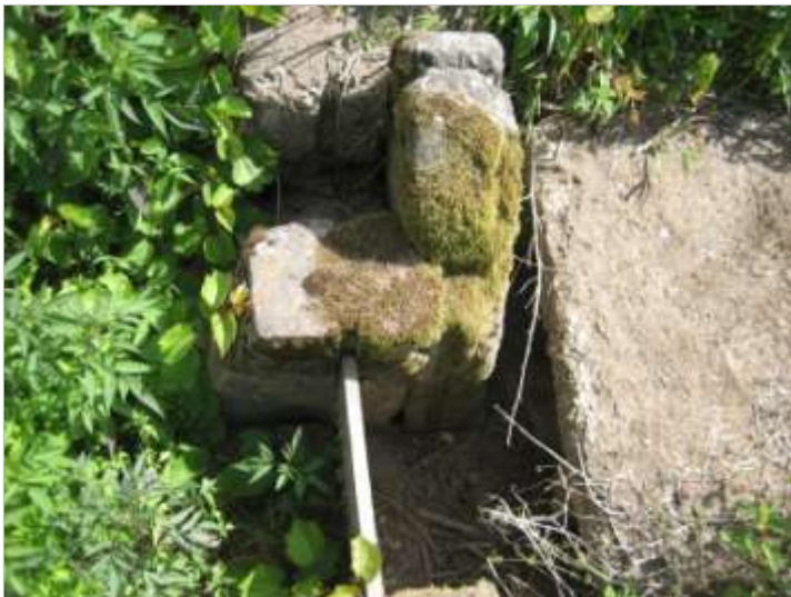
Fig. 125. Encaixe da comporta no murete de cimento
