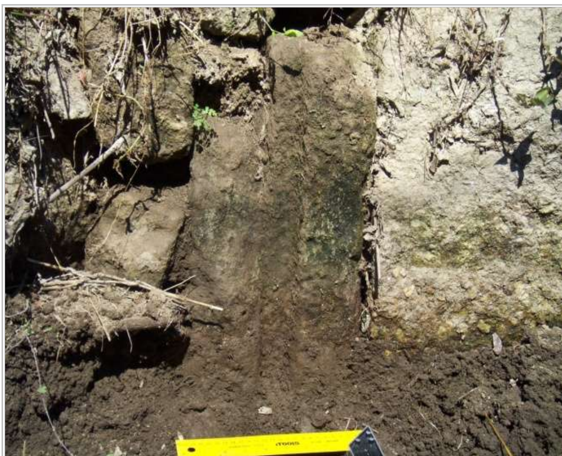
Fig.74. Pilar de comporta
