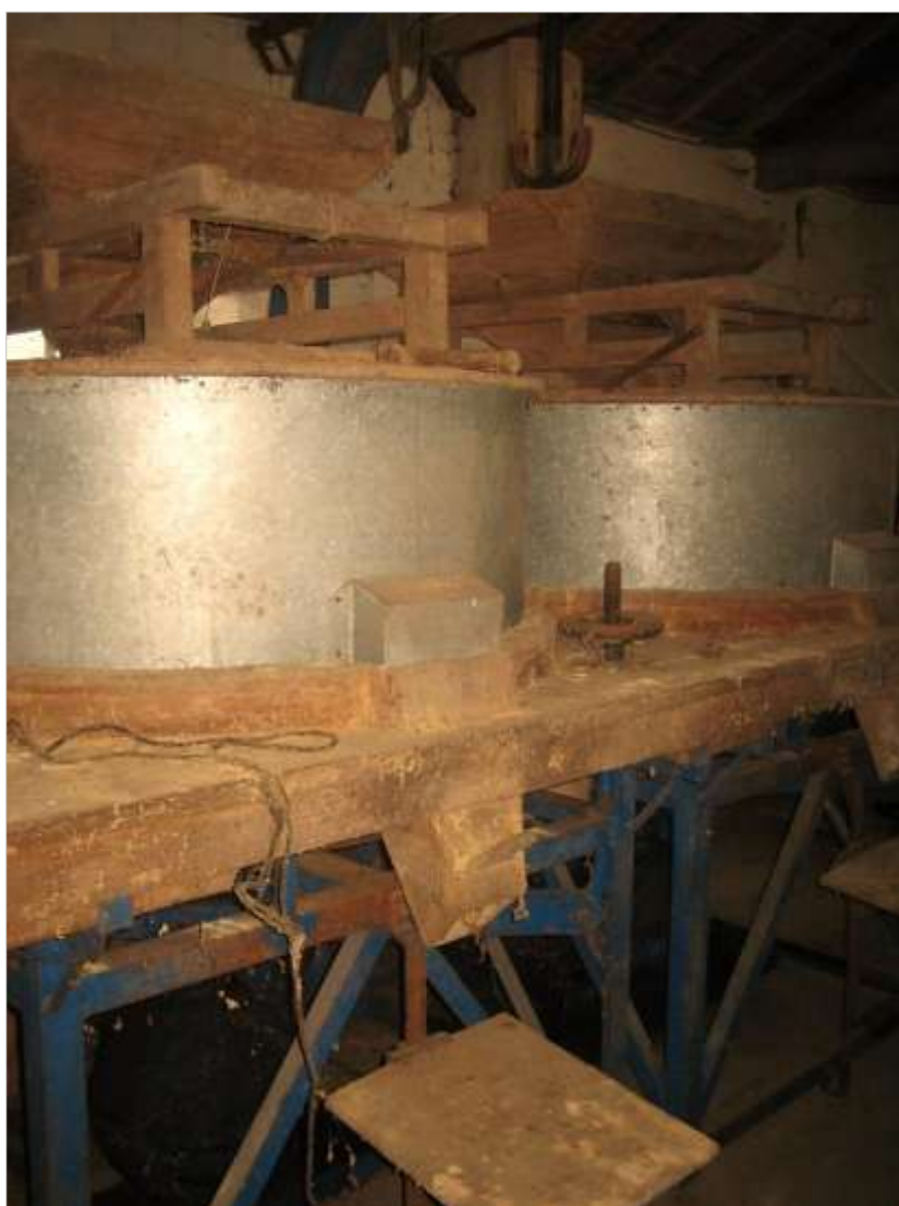
Fig. 19. Moendas acionadas a energia elétrica
