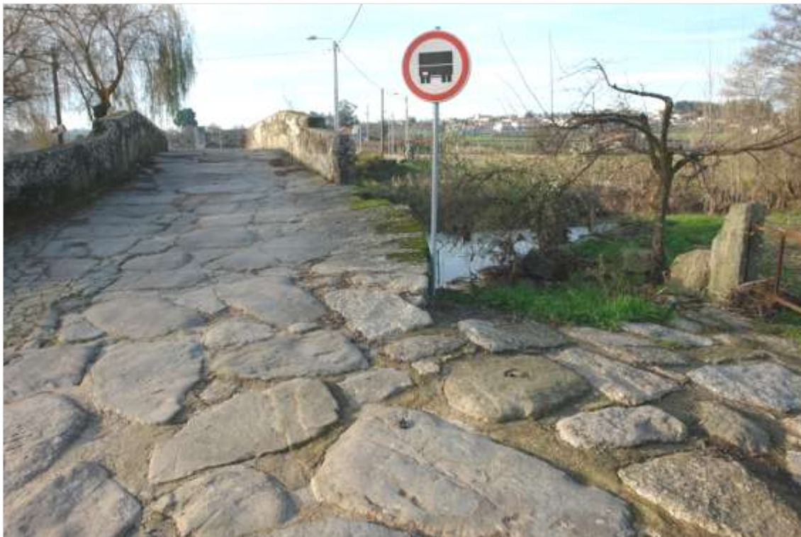
Fig.7. Rampa de acesso ao rio e à cancela de Secortinhas . Margem esquerda.
