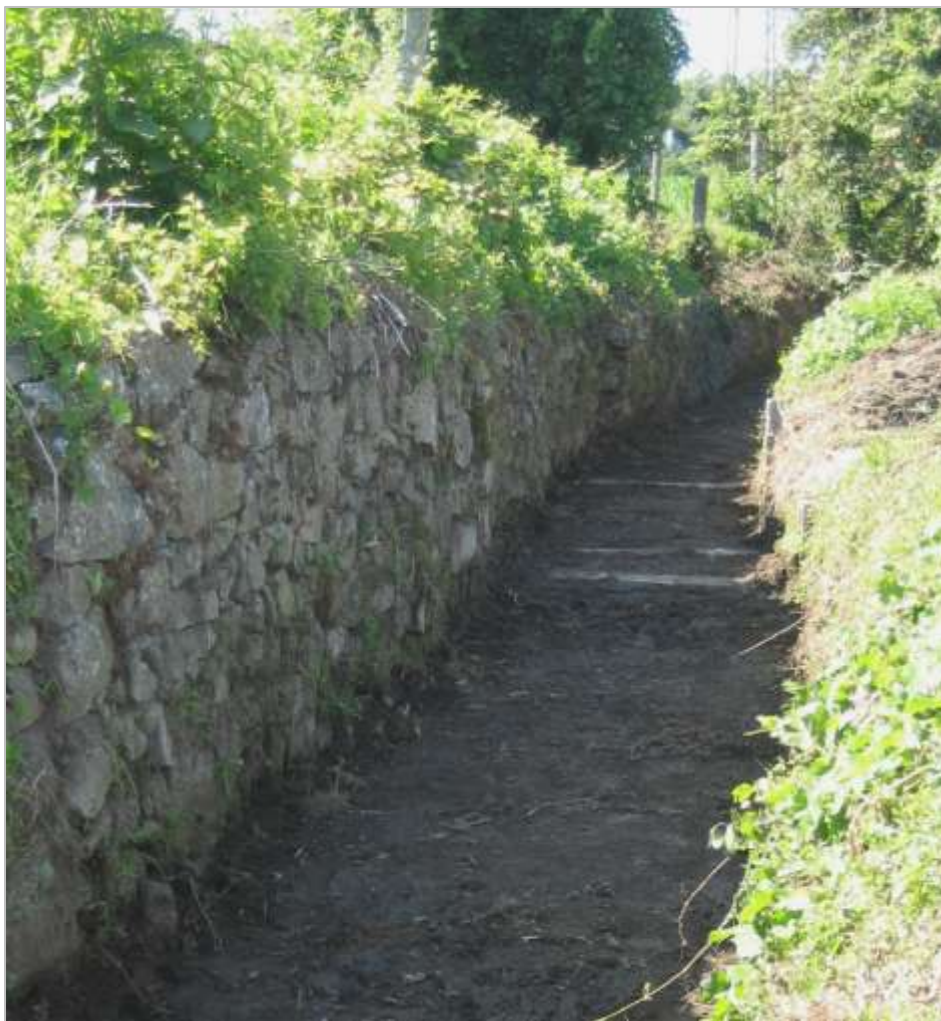
Fig. 77. Soleiras transversais ao canal.
