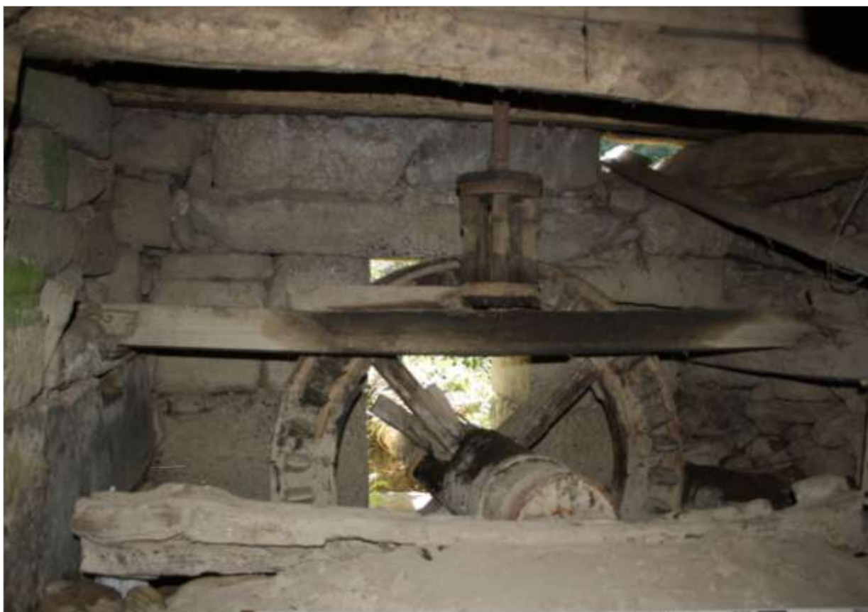
Fig. 13. Entrosca da engrenagem a jusante
