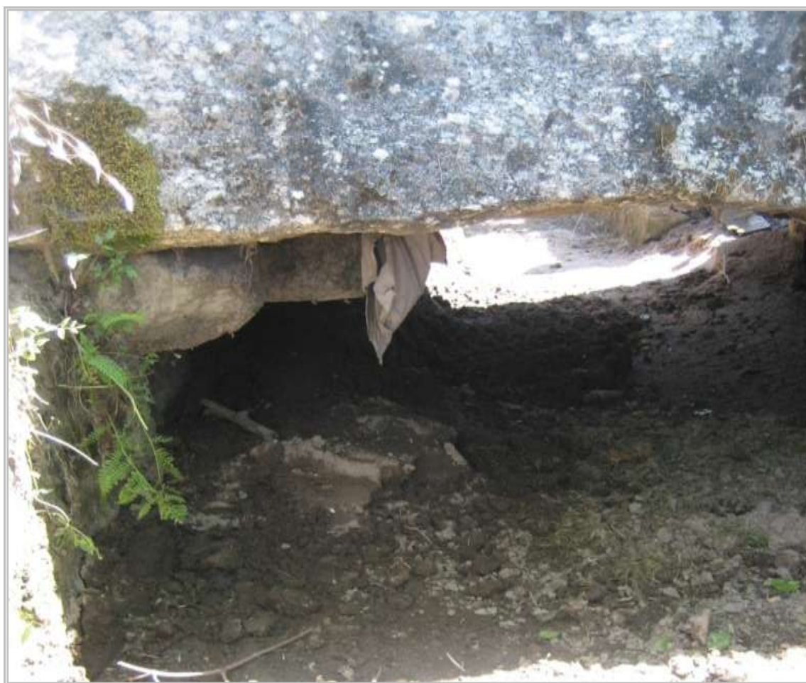
Fig. 11. Pontilhão em “Gomes”.
