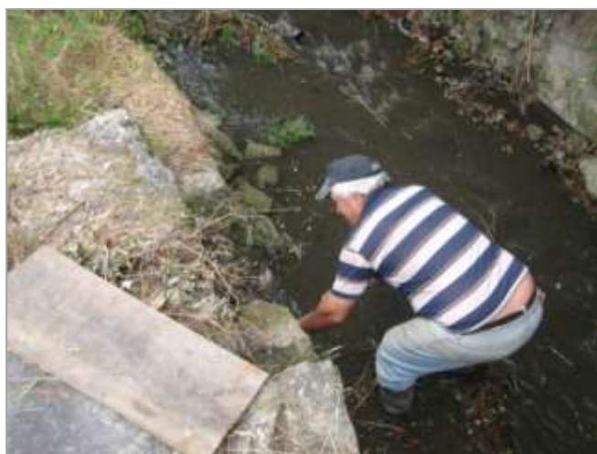
Fig.35 e 36. Início das regas. Remoção dos entulhos e areias trazidos pelas primeiras águas. Introdução da comporta para fecho do canal.
