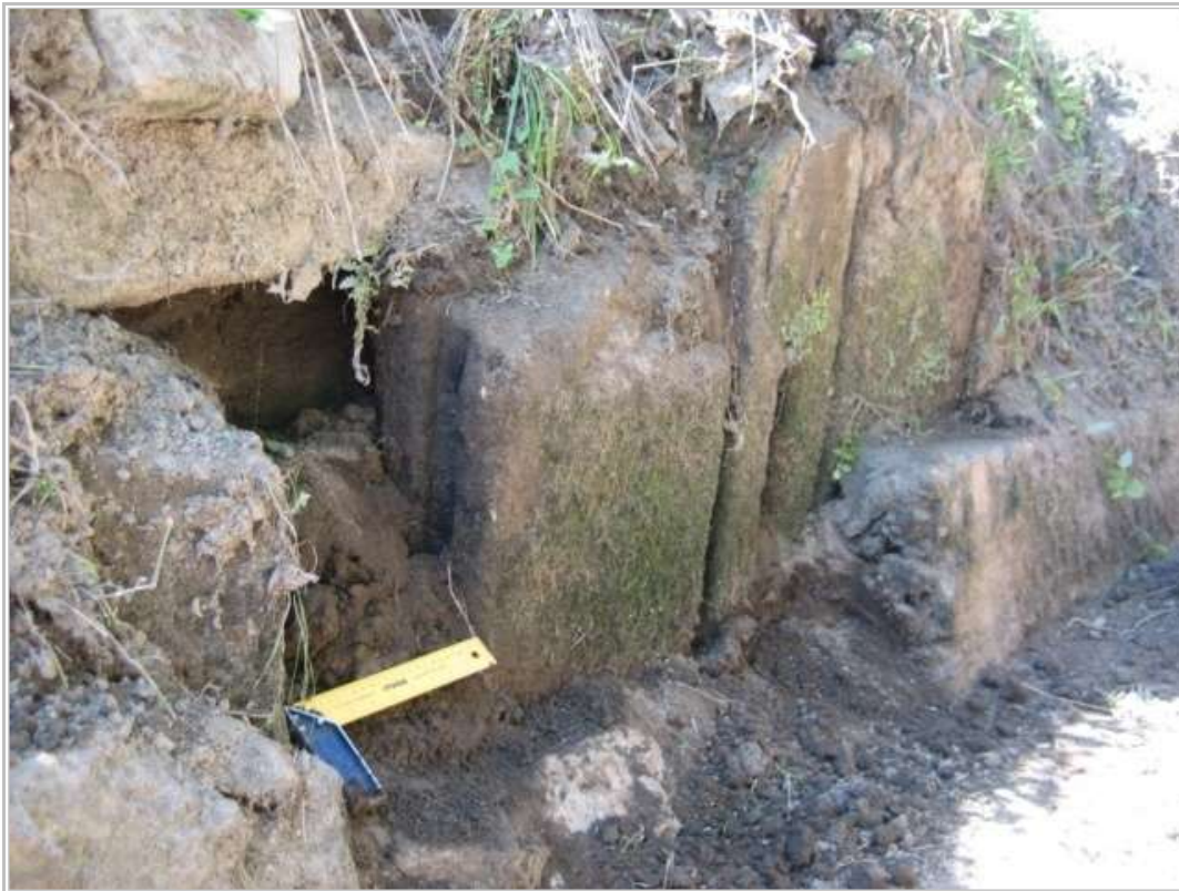
Fig.3. Registro de rega aterrado.
