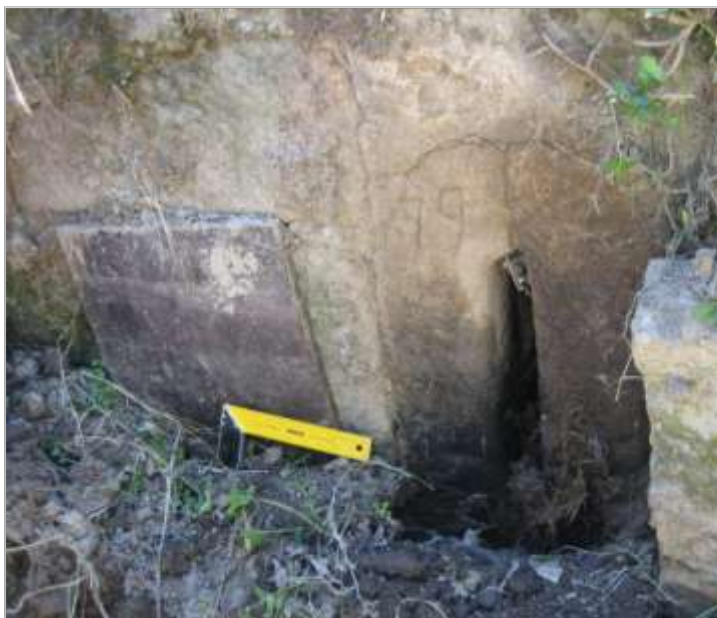
Fig.22. Registro adossado a montante do pontilhão
