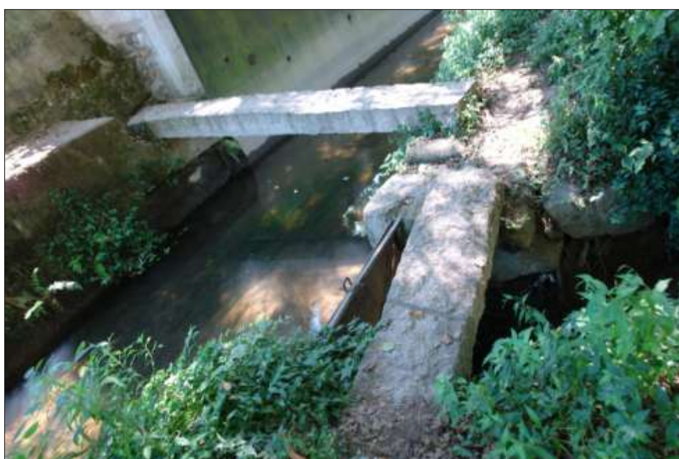
Fig.18. Boca do canal mestre e comporta lateral do açude
