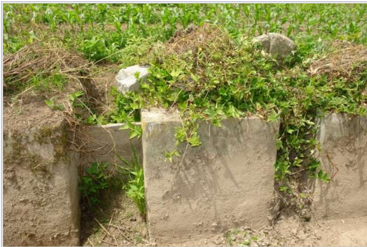
Fig. 133. Muretes de betão que delimitam este troço do canal mestre.
