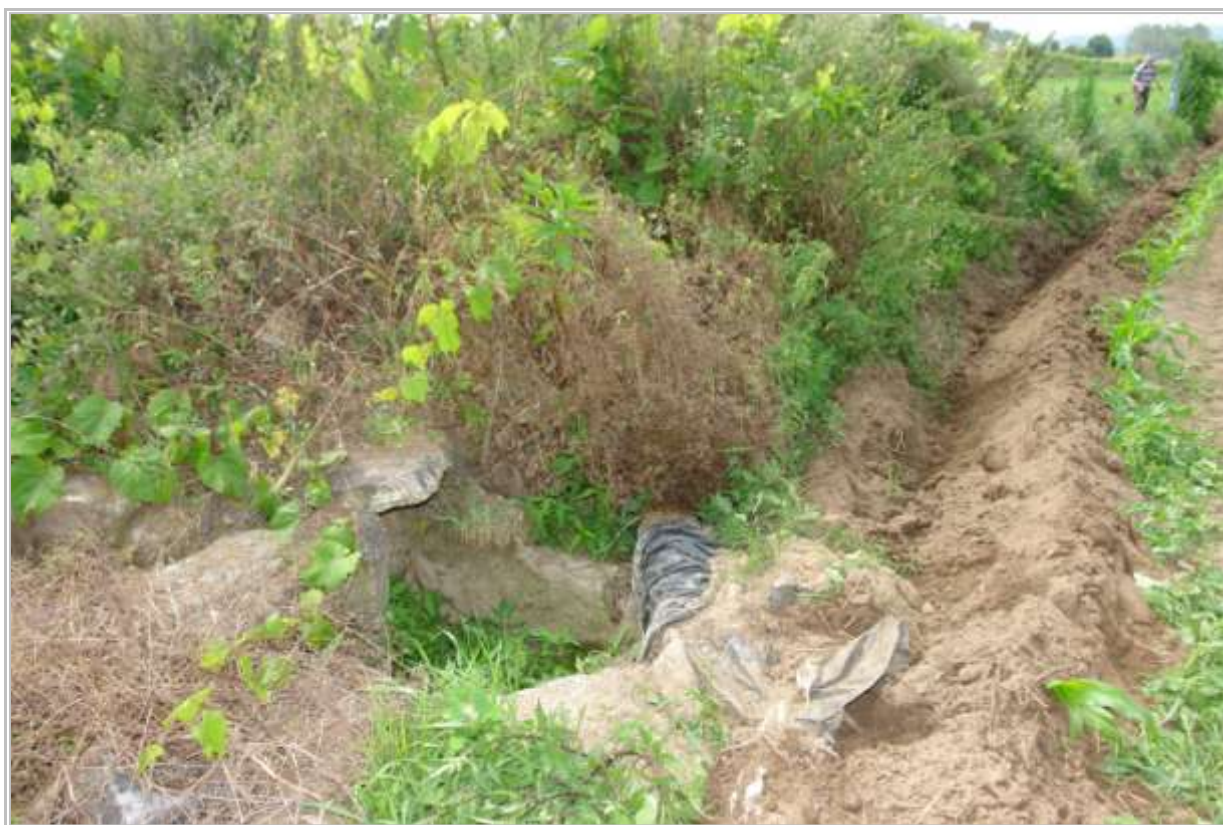
Fig. 136. Arranque do rego a céu aberto que corre paralelo ao canal mestre e à testeira da parcela contígua.
