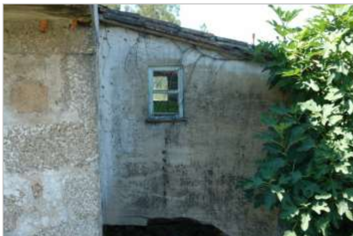
Fig.5. Passadiço sobre o canal das rodas verticais
