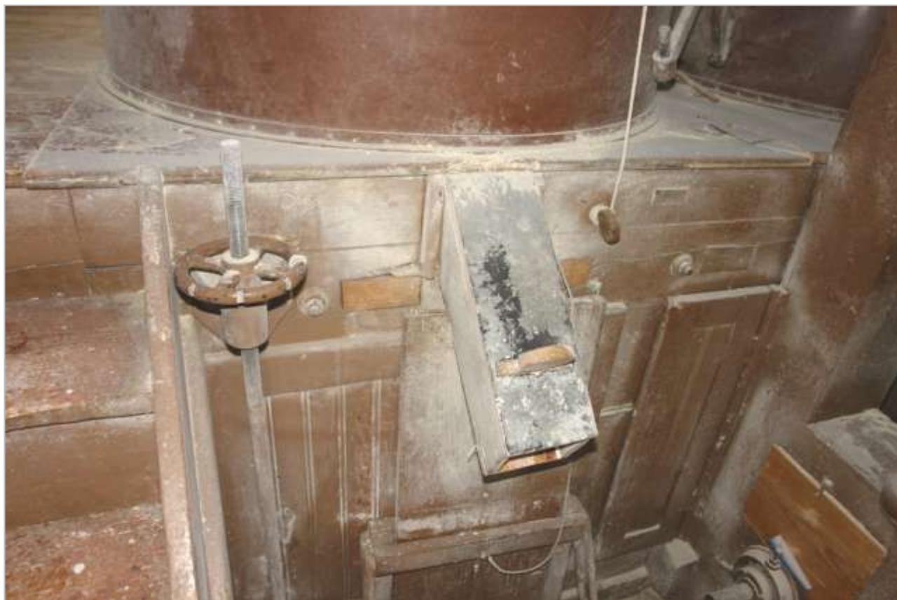
Fig. 25. Aliviadouro e portinhola de acesso ao cabouco
