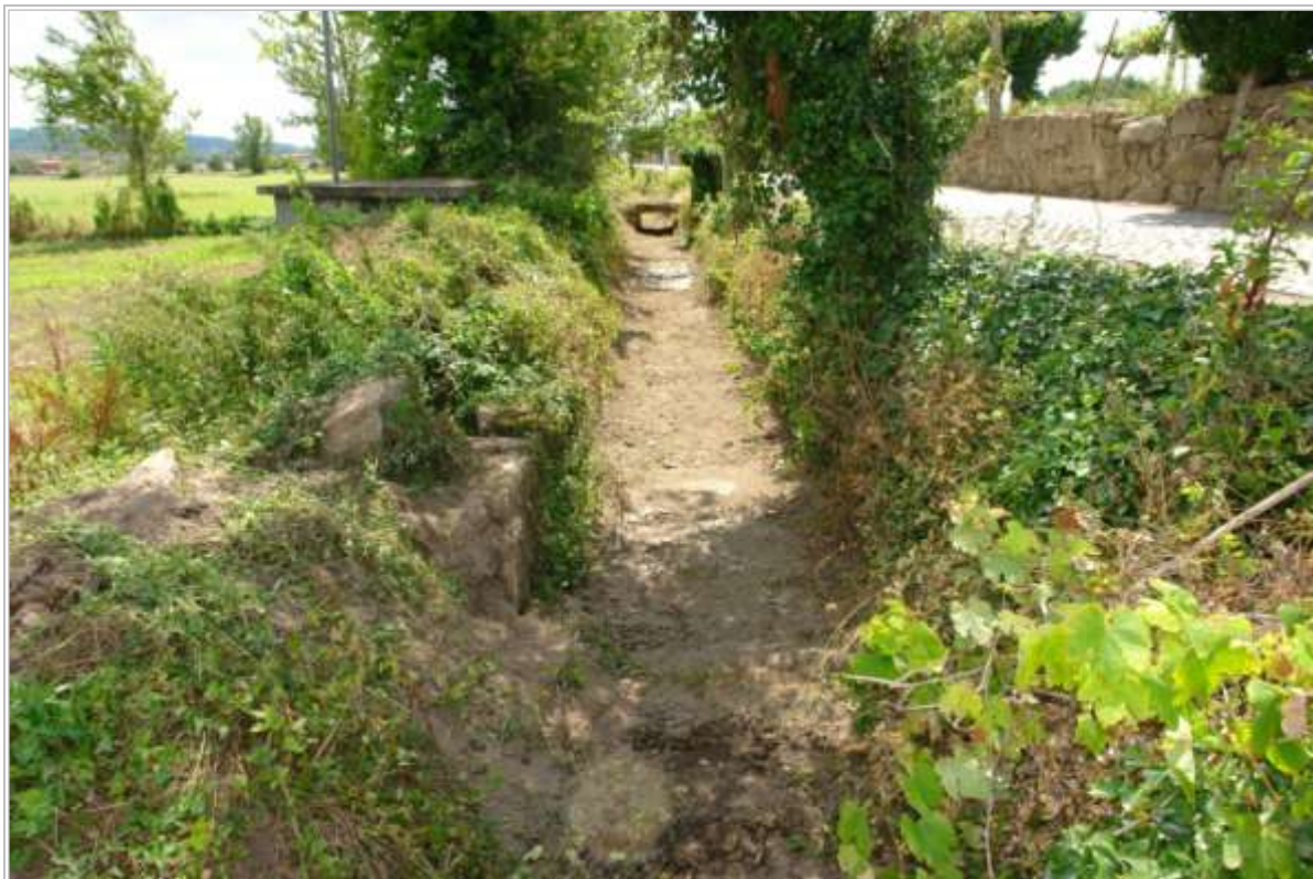
Fig.48. O canal corre paralelo à estrada.
