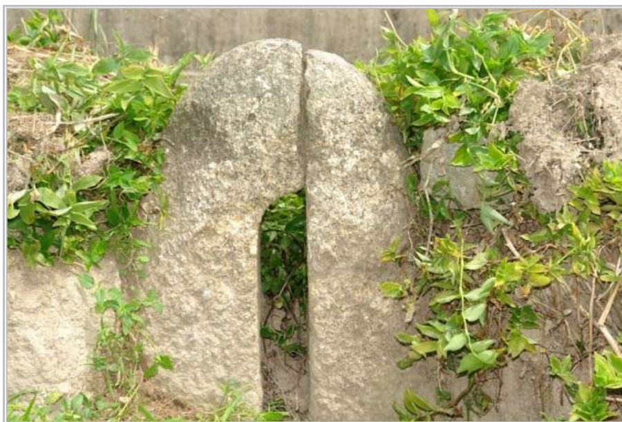
Fig. 132. Vista do interior do registo granítico.
