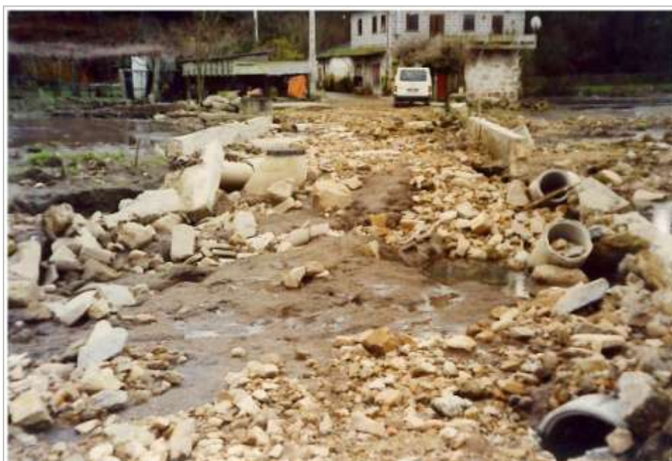
Fig.31 e 32. Primeira tentativa de construção do caminho de acesso à azenha destruído pelo rio. Anos noventa do séc. XX 154
