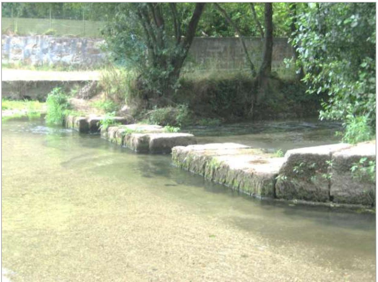
Fig.2. Paramento a montante. Junho 2012
