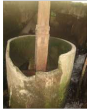
Fig.34. Rodete em baça de cimento. Azenha do Trigo, Gondifelos.
