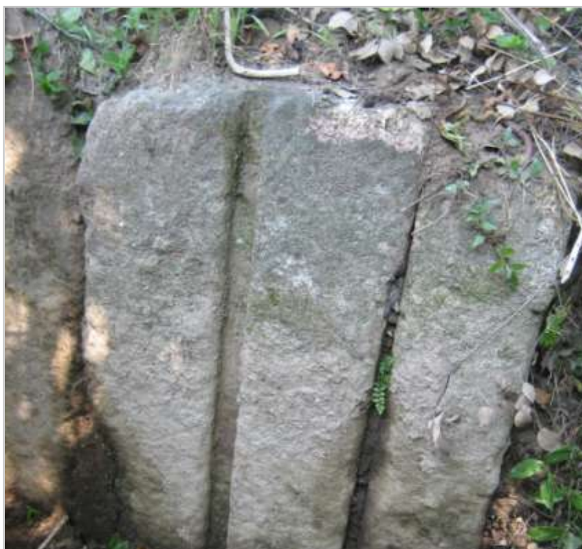
Fig. 85. Pilar de comporta
