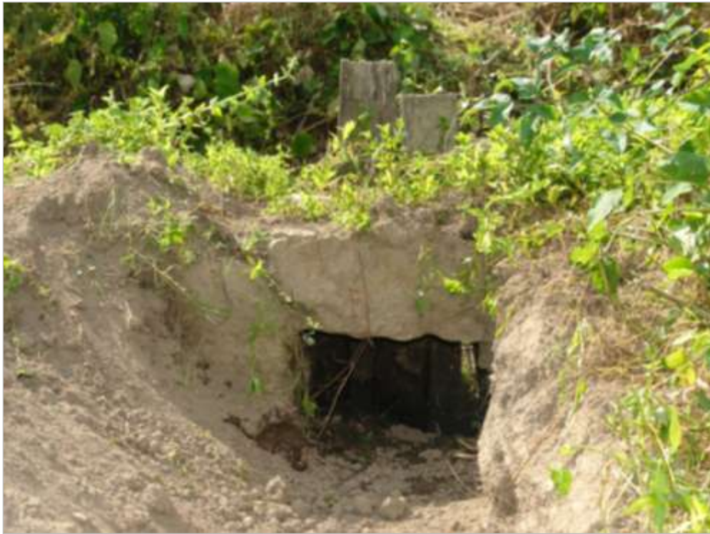
Fig. 37. Vista interior do registro
