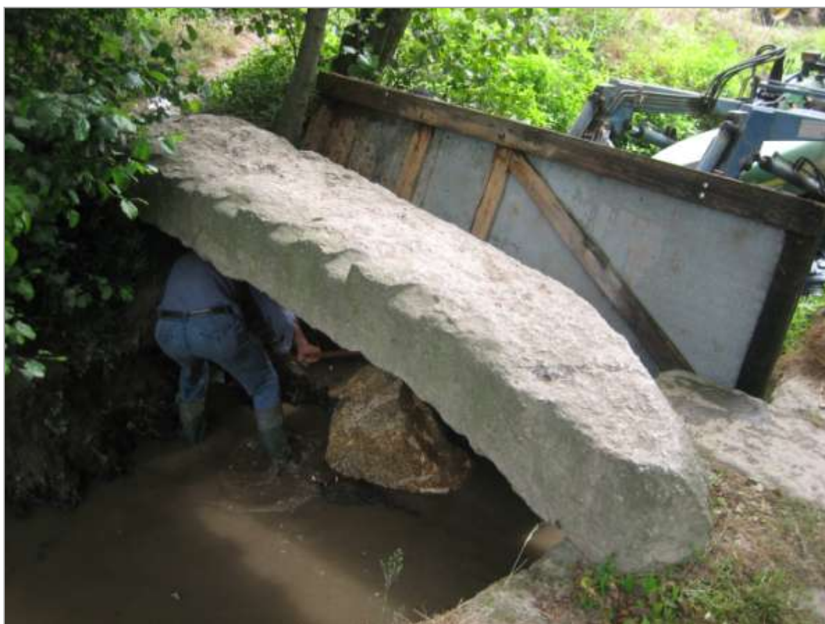
Fig. 26. Colocação da comporta
