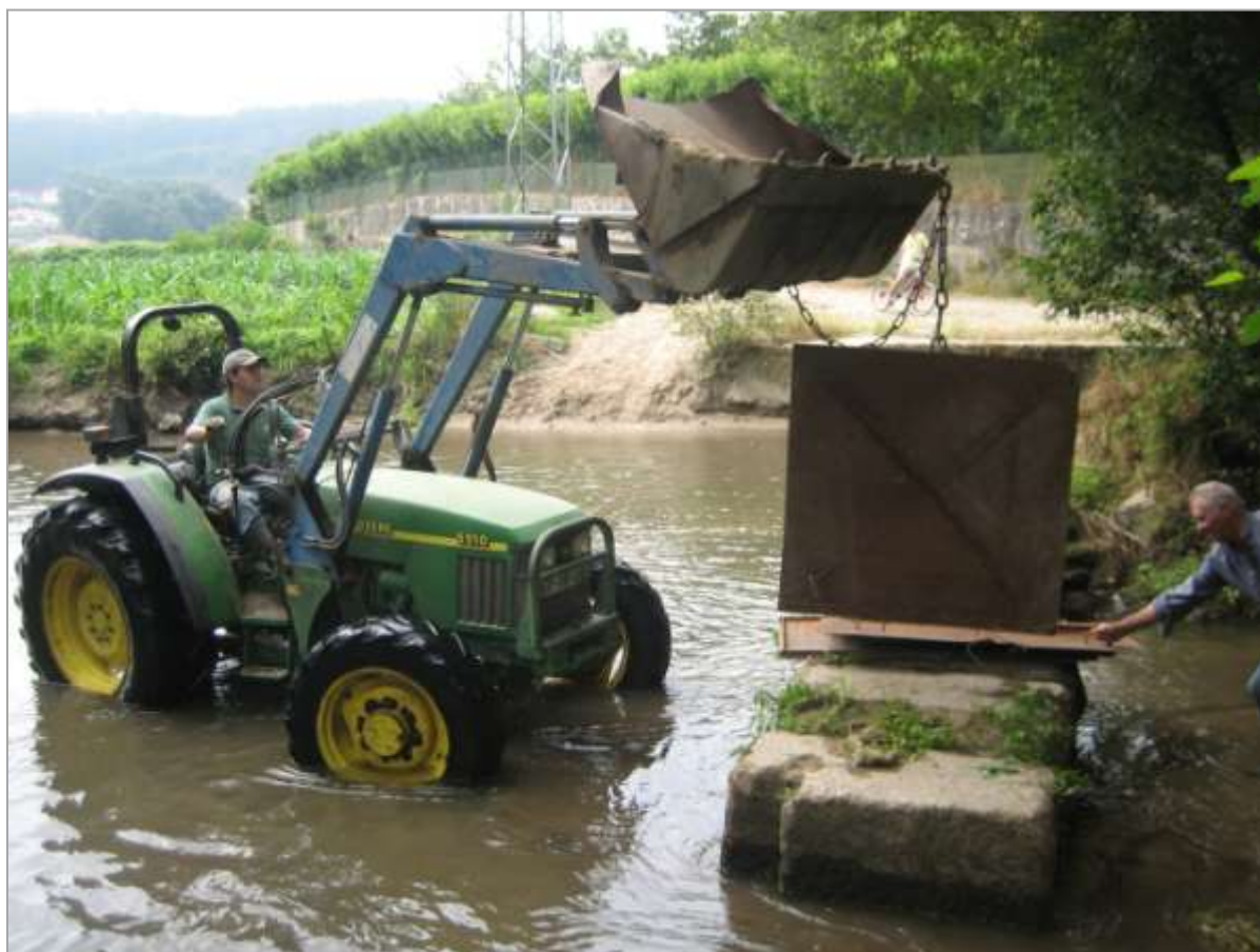
Fig. 14. Fecho do açude e calafetagem das comportas.
