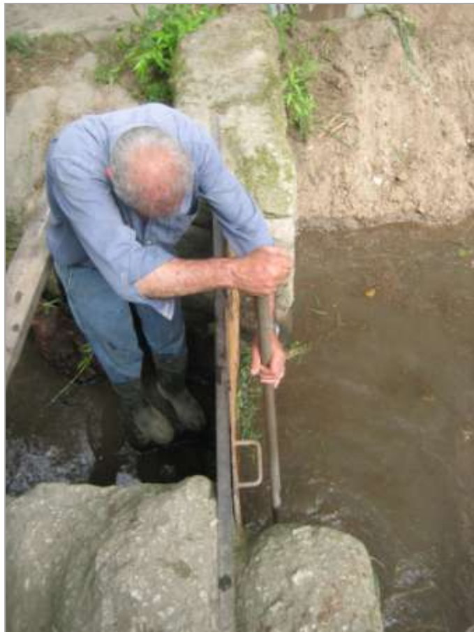
Fig. 30. Calafetagem do sangradouro. Margem direita.
