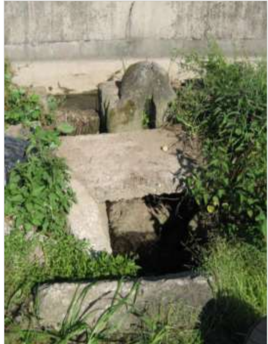
Fig. 124. Reforço da estrutura com uma laje de cimento
