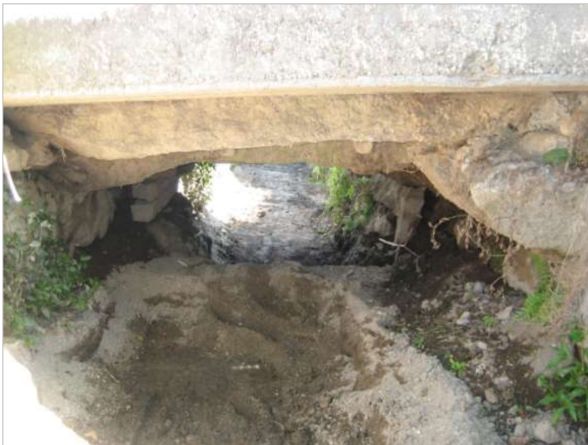
Fig. 79. Degrau do canal
