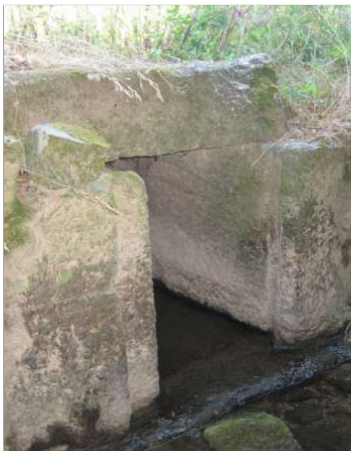
Fig.34. Boca do canal de drenagem, lugar da Borrallheira, Nine.
