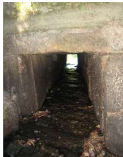
Fig. 39. Interior do canal ou sangradouro
