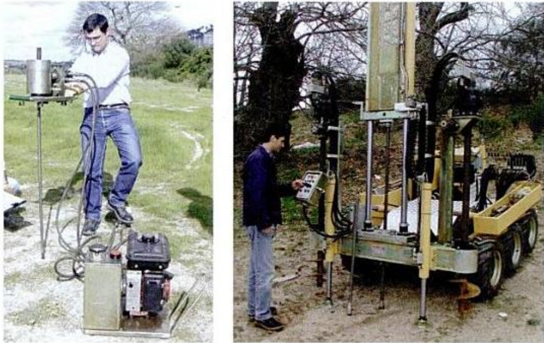
Fig. 4.3 - À esquerda: execução do ensaio DPL; À direita: execução do ensaio DPH (Matos Fernandes, 2011b)
