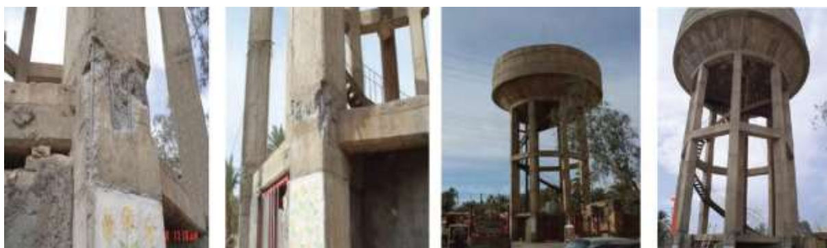
Figura 9 - Tanque elevado de água localizado em Bam, Irão [24].
