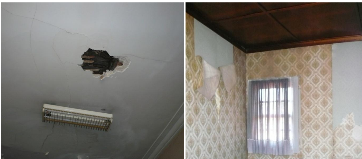
Figura 5.5 – Composição do teto estucado (à esquerda) e vista do teto em contraplacado de madeira (à direita)
