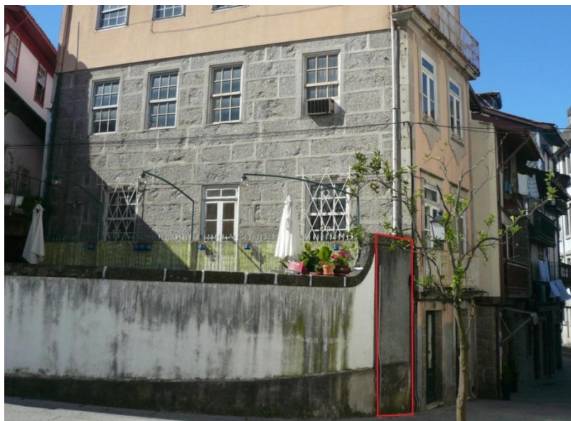
Figura 5.7 – Muro de vedação do logradouro
