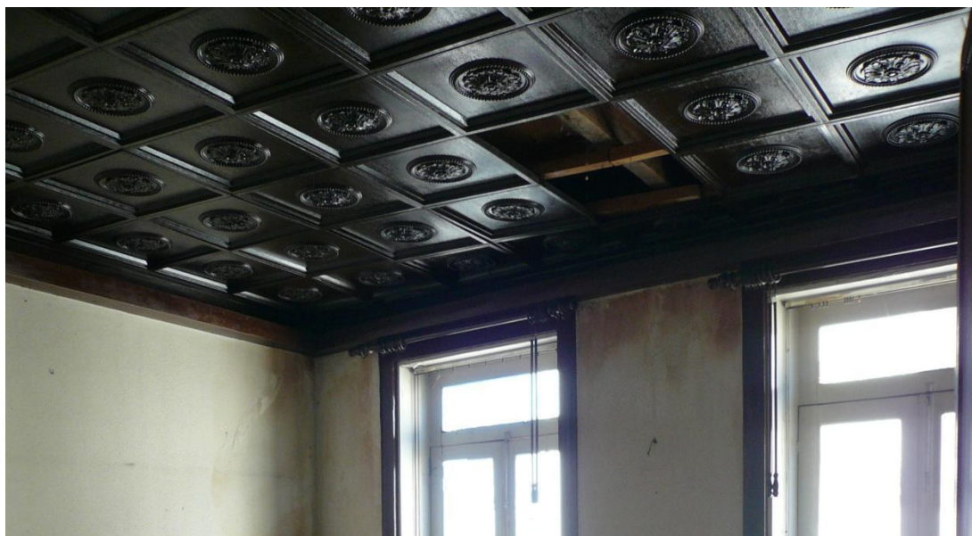
Figura 5.4 – Vista do sistema de vigamento do 3º andar, através do teto do 2º andar
