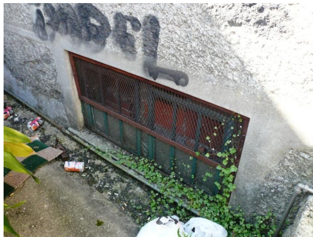
Figura 5.14 – Janela de ligação entre o logradouro e o espaço interior do rés-do-chão
