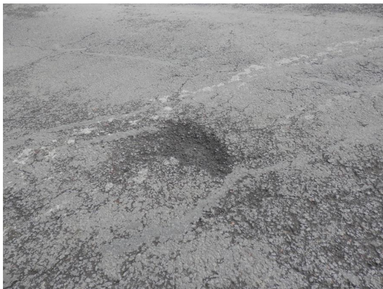
Fig.2.5. - Ilustração de um Ninho de nível 3. [Extráida de Inspeção Visual a um pavimento rodoviário realizada em 14/04/2014]
