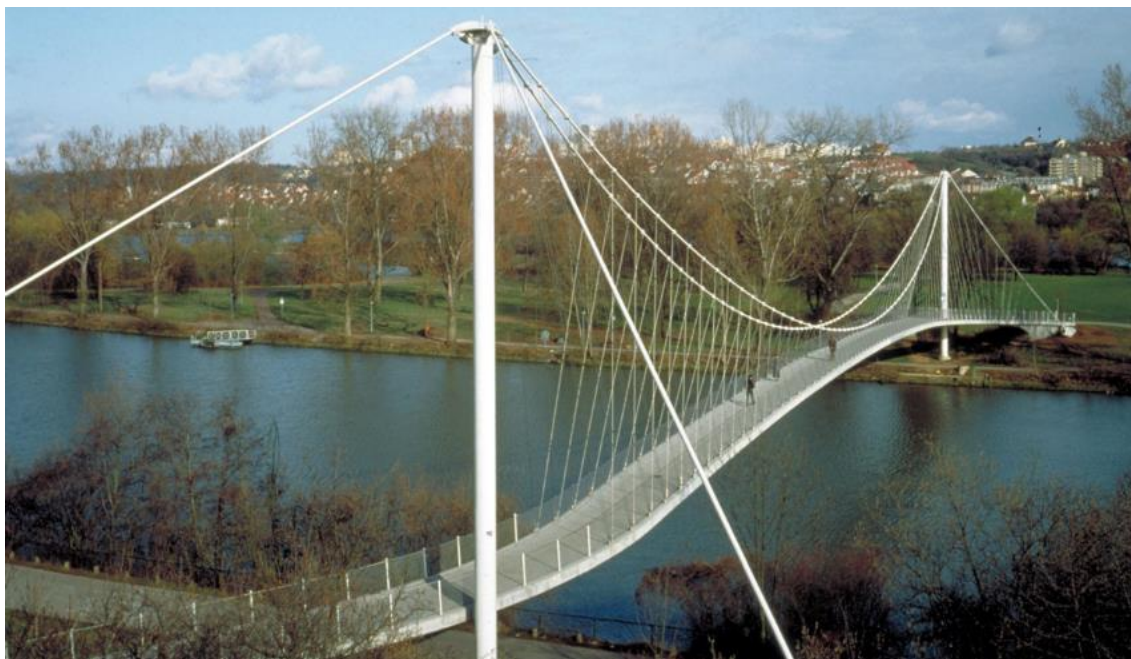
Figura 2.2 – Ponte pedonal suspensa sobre o Lago Max Eyth, Estugarda
