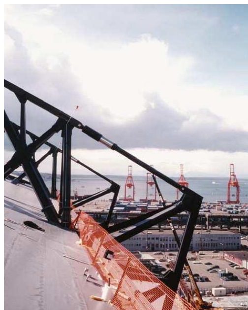
Figura 5.2 – Exemplo de aplicação de um amortecedor viscoso no Estádio Pacific Northwest, em Washington, EUA [22]
