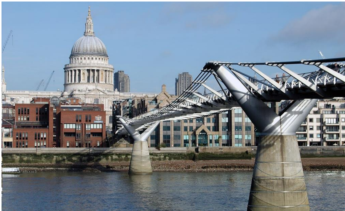
Figura 2.3 – Vista da Millenium Bridge, Londres
