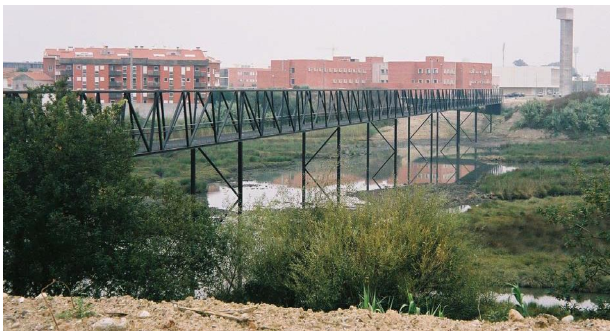
Figura 3.12 – Vista da ponte pedonal sobre o Esteiro de São Pedro, Aveiro [18]
