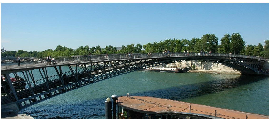
Figura 2.28 – Vista da Passerelle Solferino, Paris
