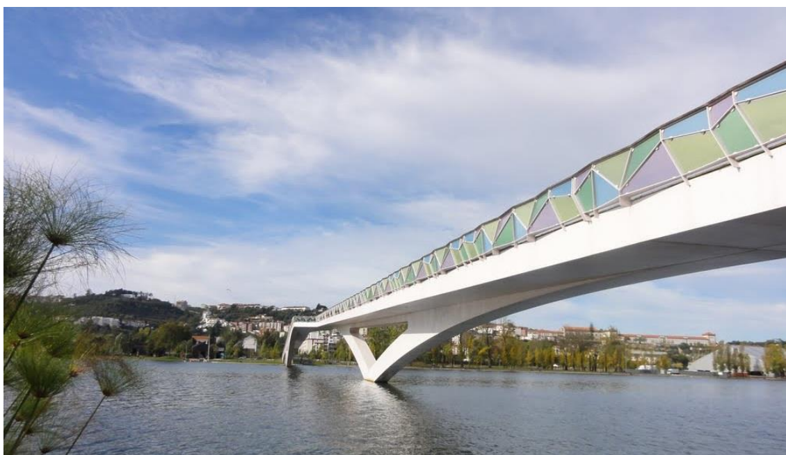
Figura 2.11 – Vista da Ponte Pedro e Inês, Coimbra
