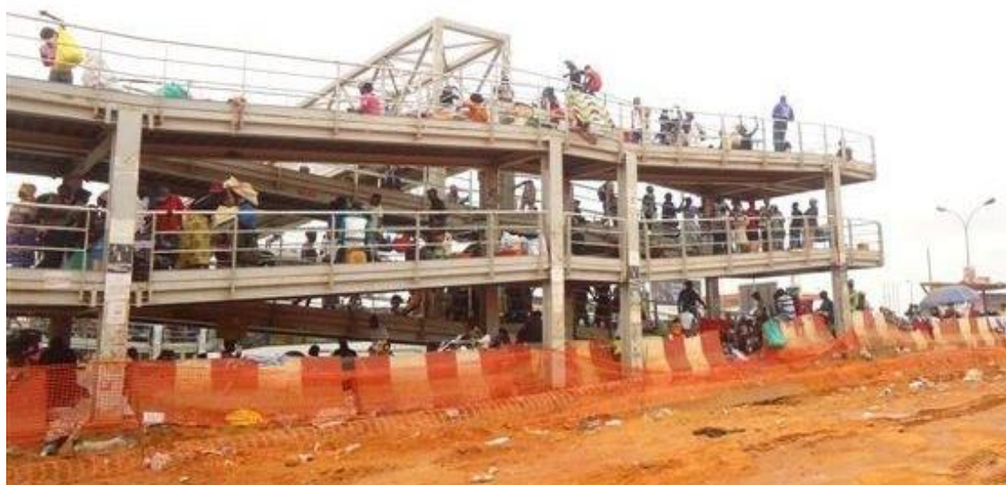
Figura 4.15 – Vista de um dos acessos à Ponte Pedonal em estudo, Luanda
