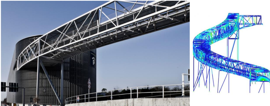
Figura 2.6 - Esquerda: Ponte Skylink, Frankfurt, Alemanha, 2011, Bollinger + Grohmann; Direita: Análise FEM da Ponte (Preisinger, C., 2013).
