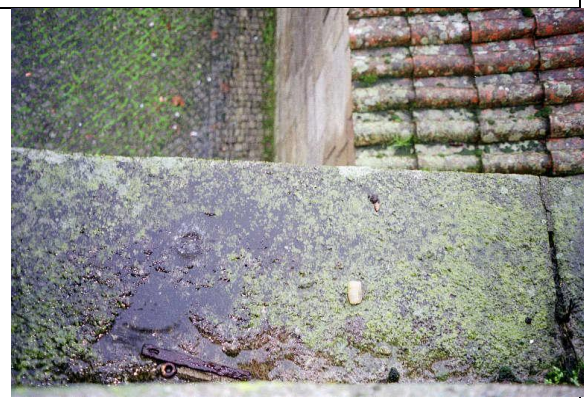
108814 Exterior: Vista superior: Muro e cobertura 2001
