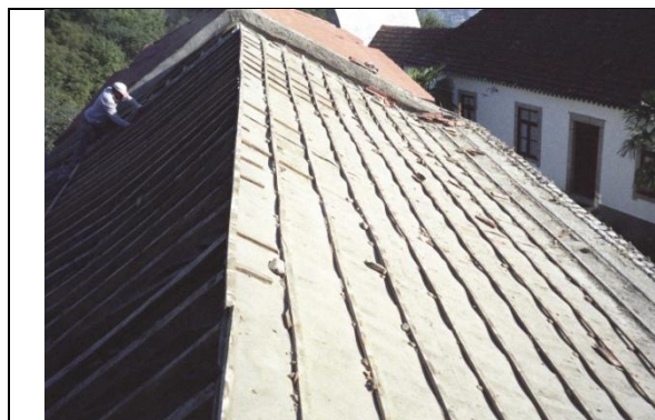
688995 Estrutura do telhado 2004
