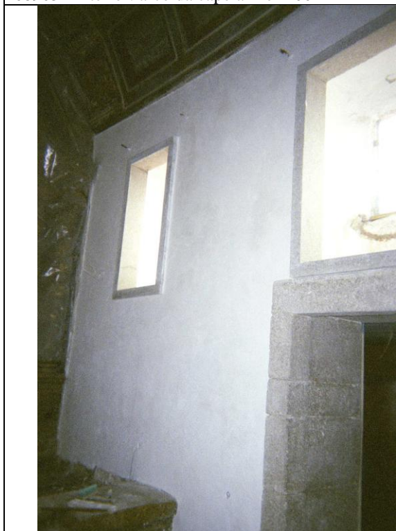
689057 Interior: janelas na capela-mor 2004
