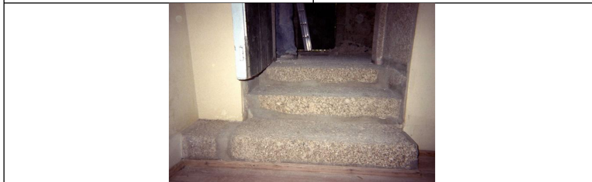
689067 Interior; degraus de acesso à sacristia 2004
