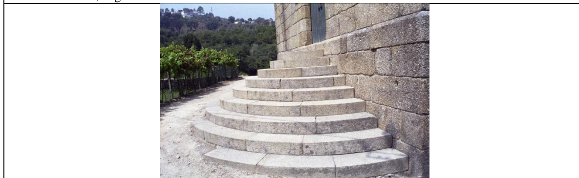
689014 Fachada principal: escadaria 2004
