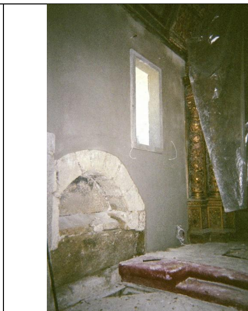
689060 Interior: pavimento e paramento da capela-mor 2004
