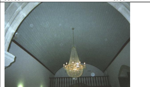
689046 Interior: tecto da nave 2004
