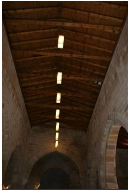
Fig. 76 Tecto com cobertura em madeira
