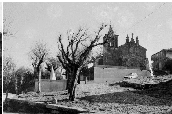
060129 Fachada principal e zona envolvente 1986
