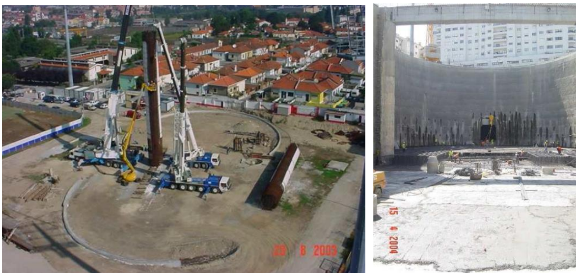
Figura 2.1 – a) Vista global do projeto da Estação de Salgueiros (construção dos poços circulares de pequeno diâmetro e da viga de coroamento); b) Vista do interior da Estação de Salgueiros na fase final da escavação
