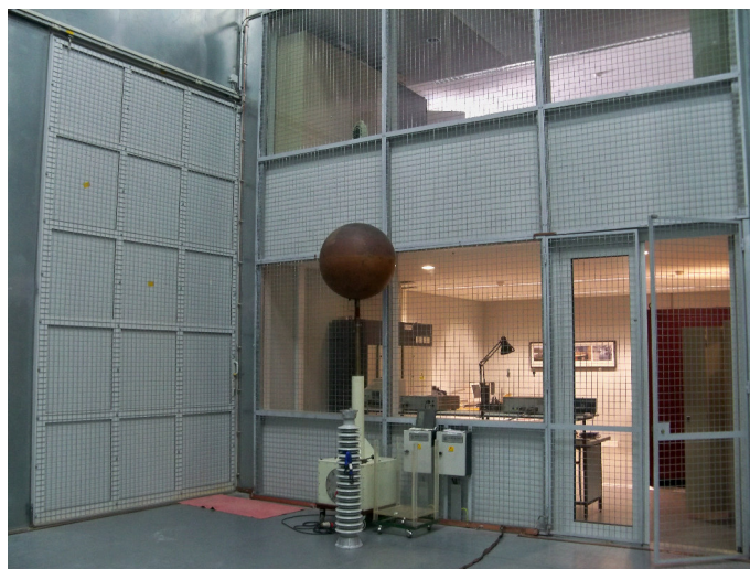
Figura 4.2: Aspetto da malha metálica utilizada para a visualização dos ensaios nas salas de comando e observação e como revestimento do portão de acesso ao exterior
