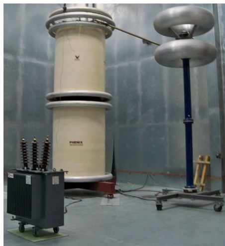
Figura 6.3: Montagem do ensaio com o sistema de frequência industrial
