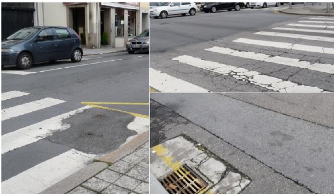
Figura 4.3. – Pormenores do piso junto ao cruzamento.
