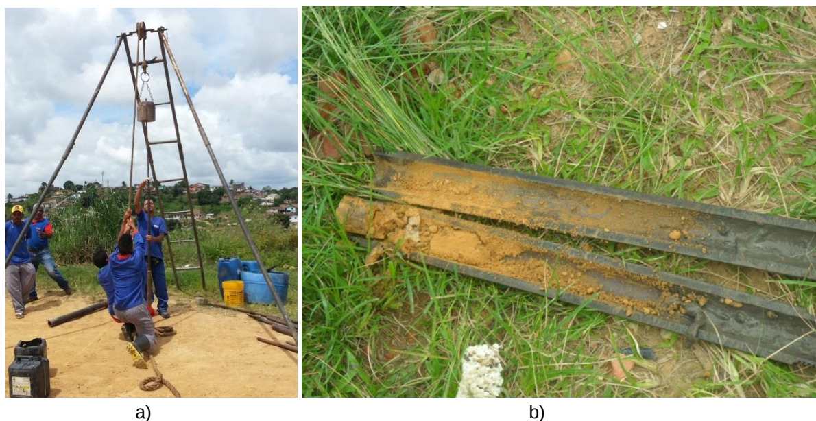
Fig. 3.9 - a) Execução ensaio SPT; b) Retirada de amostras por meio do SPT.
