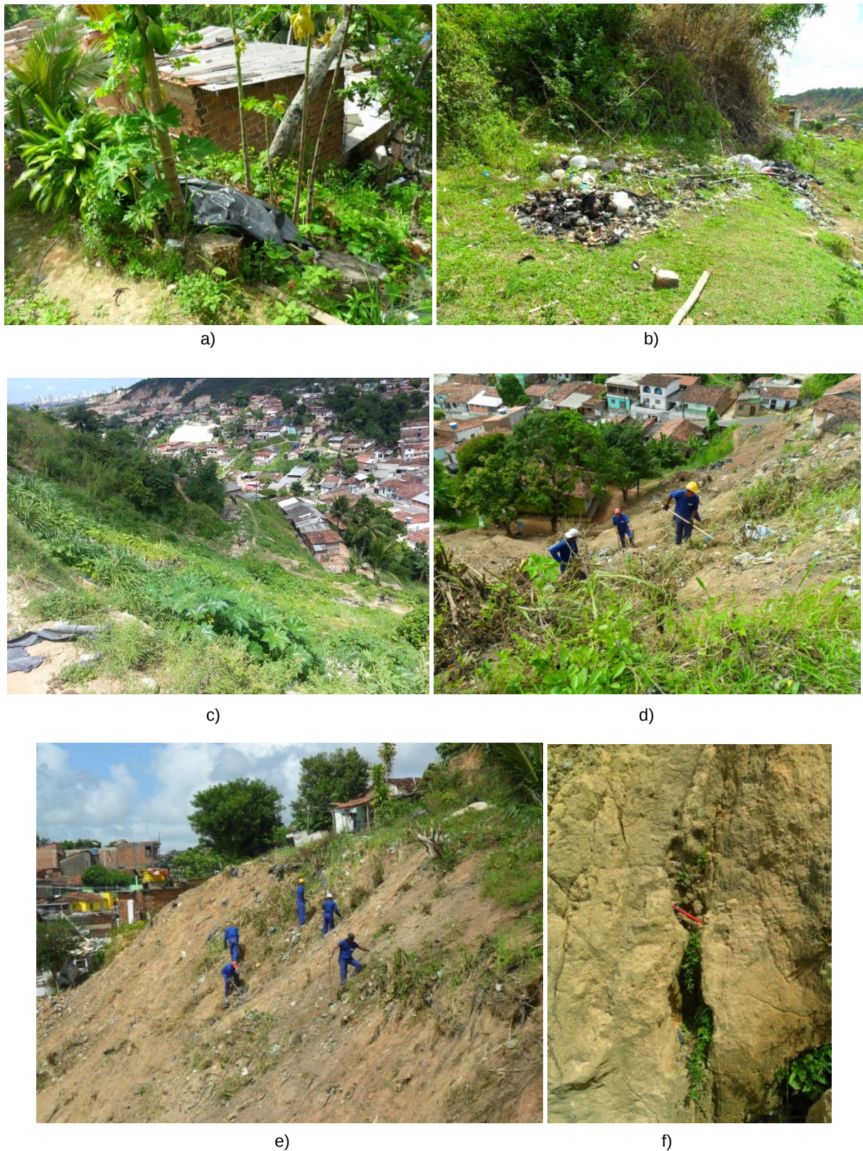
Fig. 3.2 - a) Árvores inclinadas; b) Lixo presente; c) Evidência da formação de degraus; d) Limpeza e desmatamento; e) Inclinação do talude; f) Fissuras.
