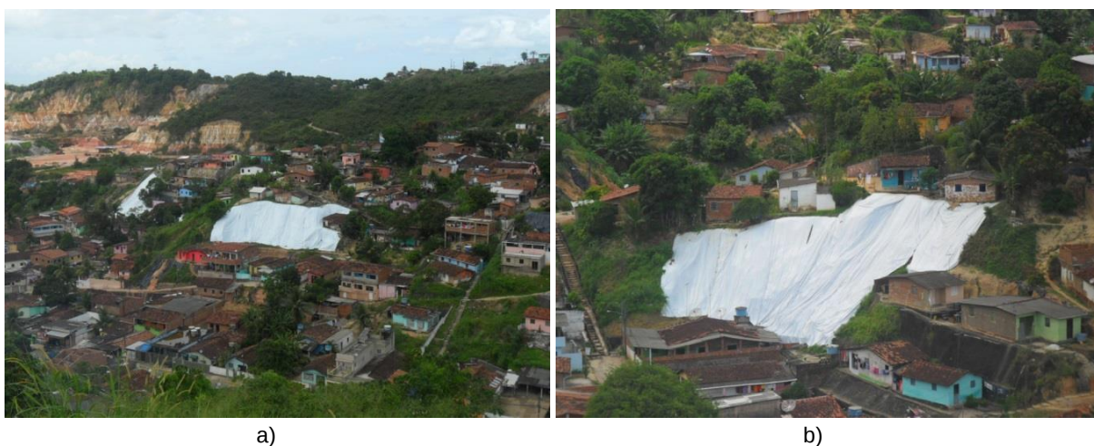
Fig. 3.4 - a) e b) Lonas impermeáveis colocadas pela Defesa Civil.
