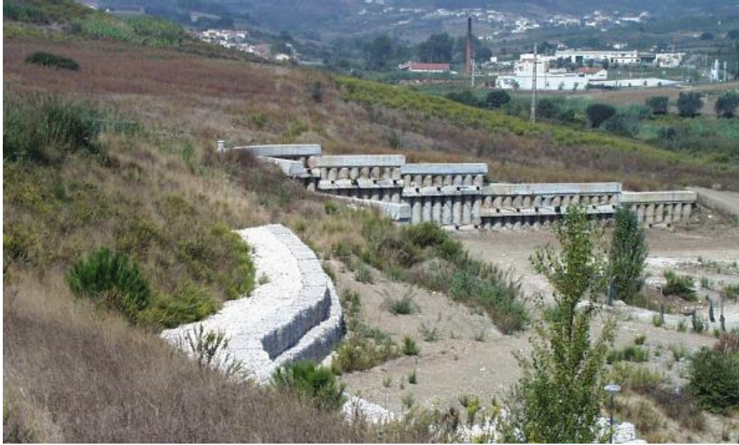
Figura 3.15 - Cortina de estacas ancorada em Merceana (LNEC,2000a) [9]
