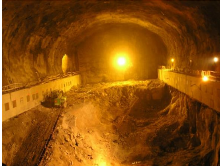
Figura 4.13 - Execução das vigas ancoradas da ponte rolante na caverna da central hidroelétrica de Salamonde II [14].
