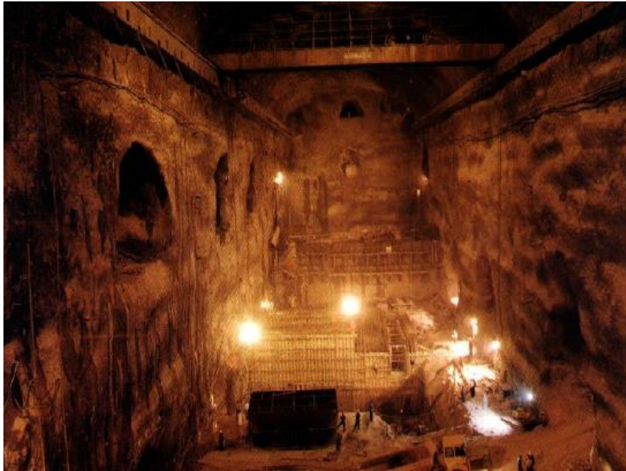
Figura 2.16 – Vista geral da central de Masjed-Soleiman durante a escavação; [7].
