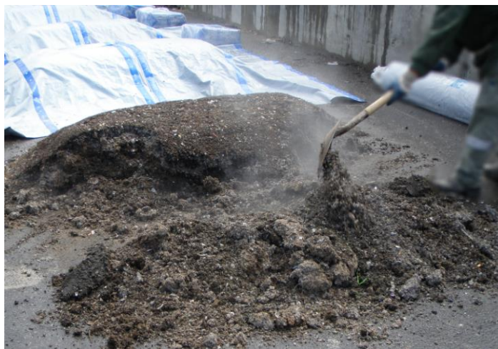
Figura 23 – Revolvimento das pilhas.
