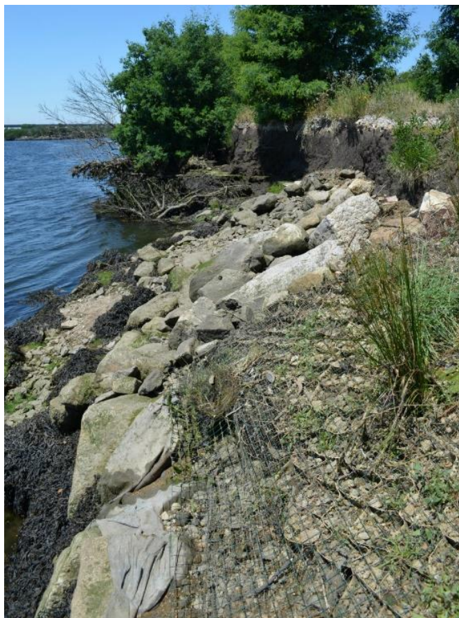
Figura 27 – Zona de remate da estrutura no troço de Portuzelo (Junho, 2014)
