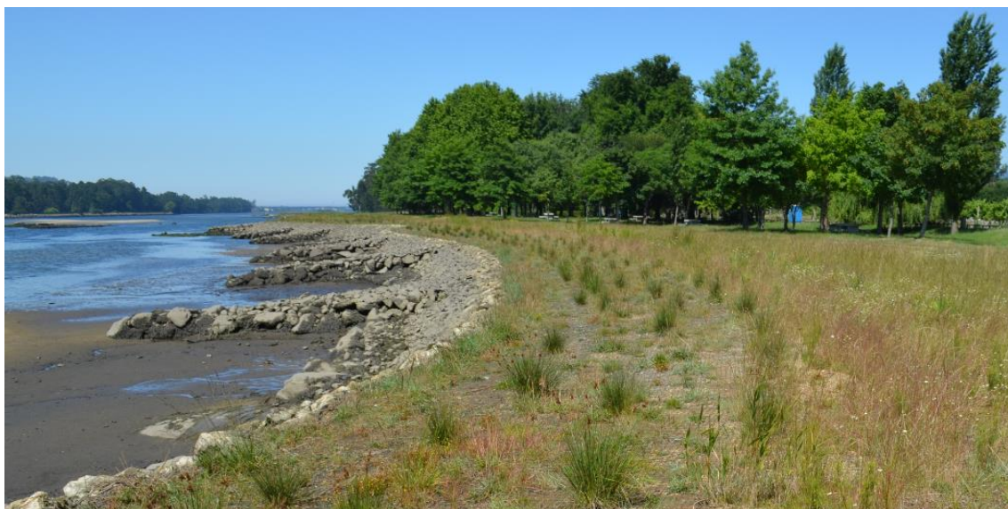
Figura 43 – Intervenção no troço de Cardielos
