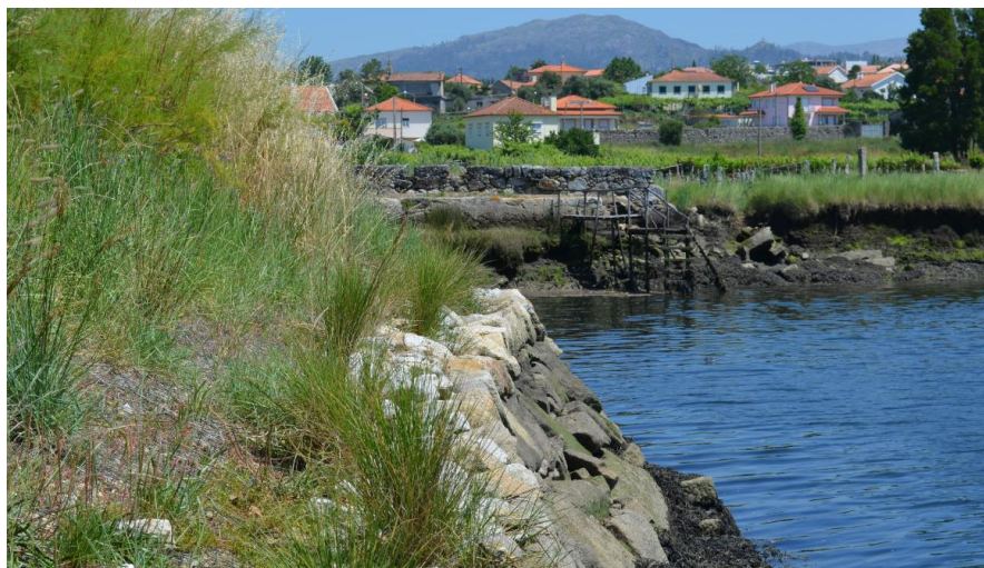
Figura 21 - Intervenção no troço de Portuzelo e sua envolvente (Junho de 2014)
