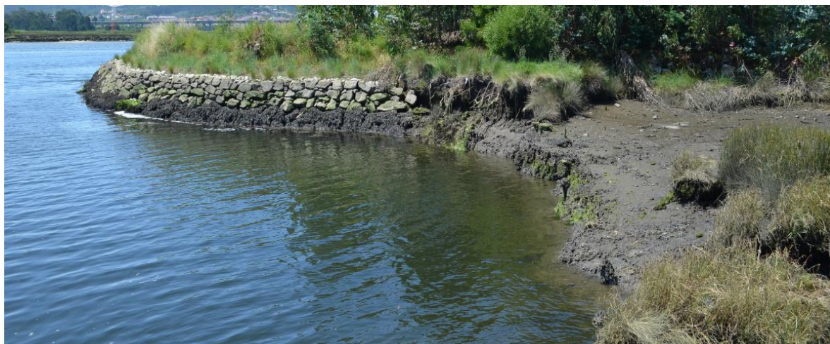
Figura 29 – Zona protegida da estrutura no troço de Portuzelo (Junho, 2014)
