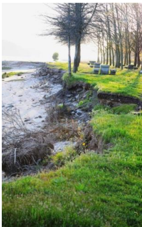
Figura 38 - Instabilidade do talude marginal antes da reabilitação no troço de Cardielos (Cortes et al , 2010)
