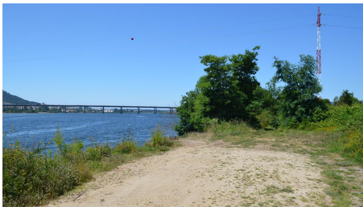
Figura 26 – Fim do caminho de acesso à intervenção no troço de Portuzelo (Junho de 2014)
