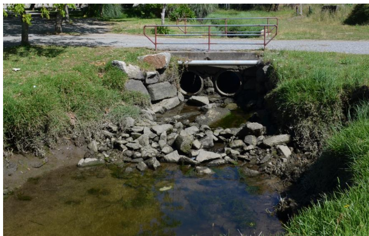
Figura 37 - Passagem Hidráulica do afluente do rio Lima no troço de Cardielos (2014)
