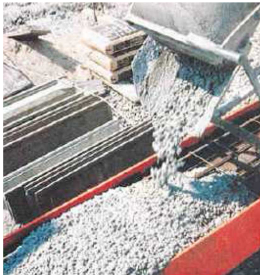
Fig.2.25 – Betonagem horizontal de um pilar parcialmente revestido (adaptado de [5])
