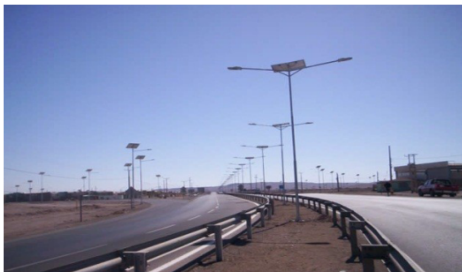
Figura 6.14: Auto-estrada iluminada por um sistema autónomo a energia solar na Cidade de Calama no Chile [69].
