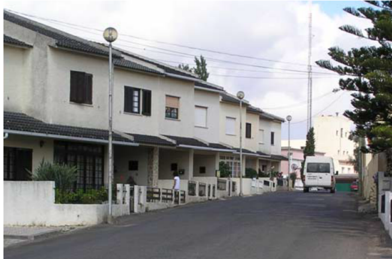
Figura 6.44: Exemplo de uso desadequado de luminárias para o tipo de via [2].
