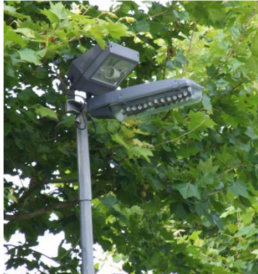
Figura 6.40: Emprego de luminárias sobrepostas [2].
