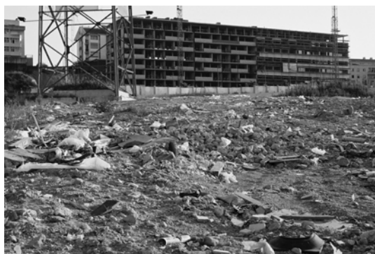
Fig. 1 – Estaleiro de construção civil nas Antas/ Porto
