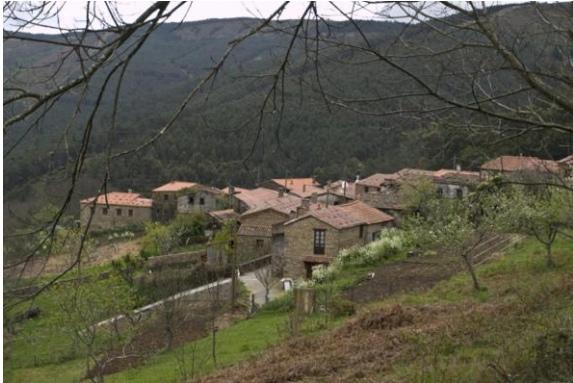
Fig.22 – Vista geral da aldeia de Gondramaz (Fonte: foto de Manuel Campos Coroa)
