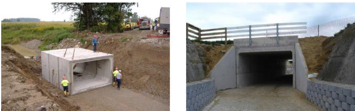
Fig. 3. 1 Box Culvert em fase de construção, à esquerda e em funcionamento à direita (Hanson et al., 2011)
