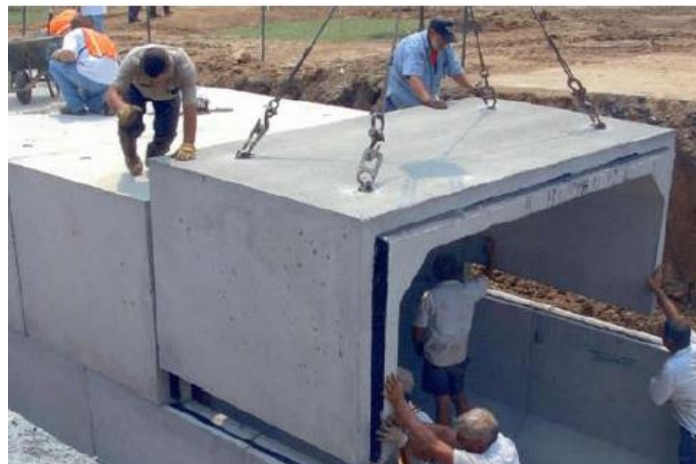
Fig. 3. 8 Colocação em obra dos Box Culvert com ligação tipo macho-fêmea (Hanson et al., 2011).
