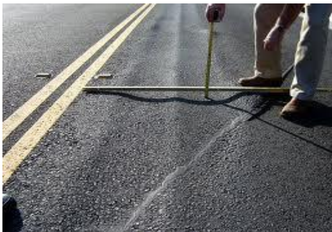
Figura 3.5: Rodeiras. Medição da profundidade com régua.
