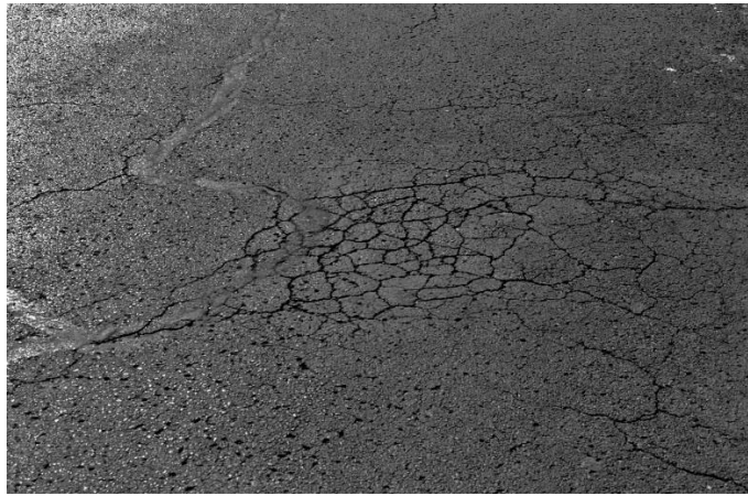
Figura 3.3: Fendilhamento tipo "pele de crocodilo"
