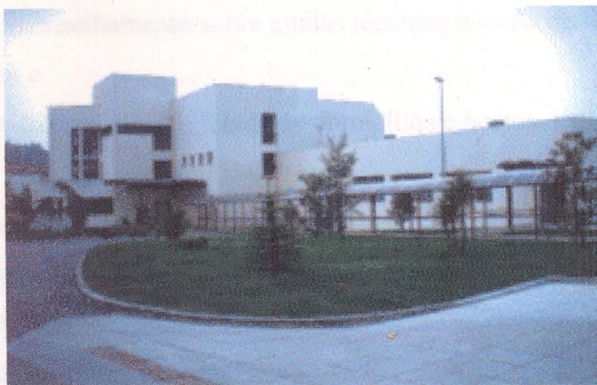
Figura 1 - O CRPGaia, em Arcozelo – V. N. Gaia [c]
