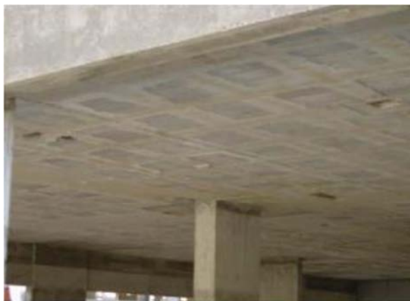
Fig. 3.6. - Laje Fungiforme Aligeirada com Blocos Perdidos [15]
