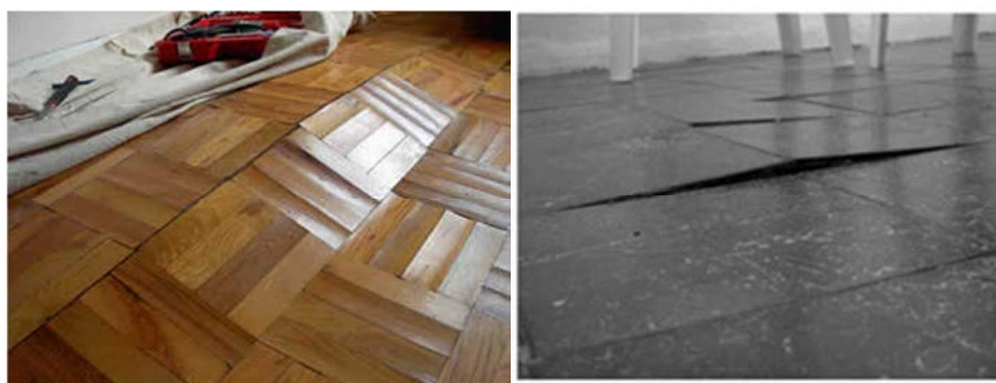
Fig. 2.7 – Empolamento de revestimentos cerâmicos
